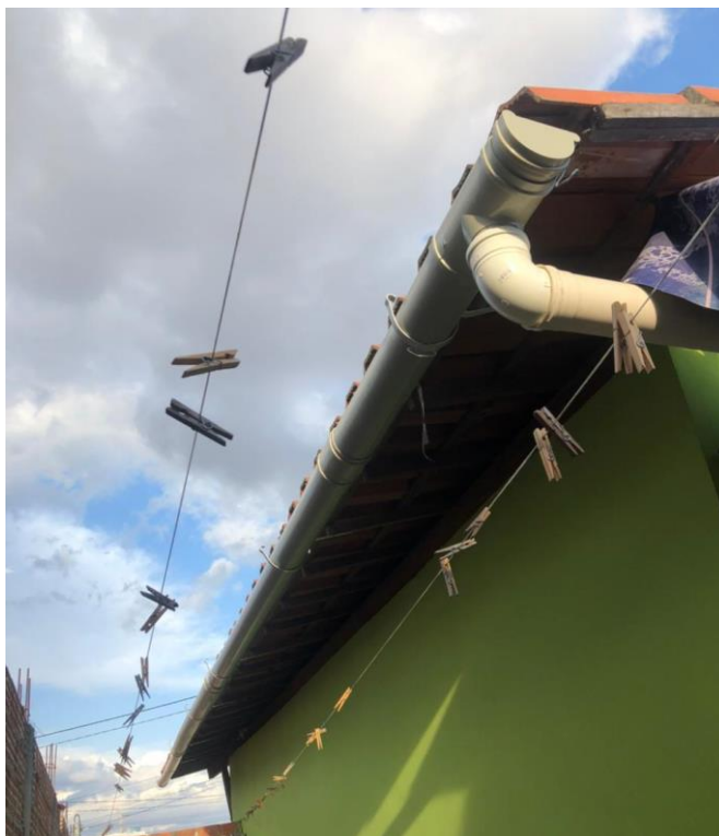
Figura 13 - Calha implantada numa das residências do empreendimento estudado
