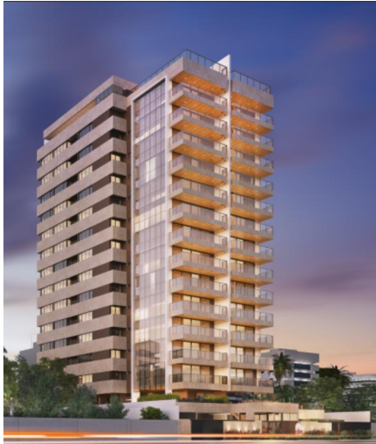
Figura C 4 - Fotografia da obra E (Tr.11Tp.1Atp.Al.Cm.G.Gs.Cb, 4Q.4S.D.V-24)
