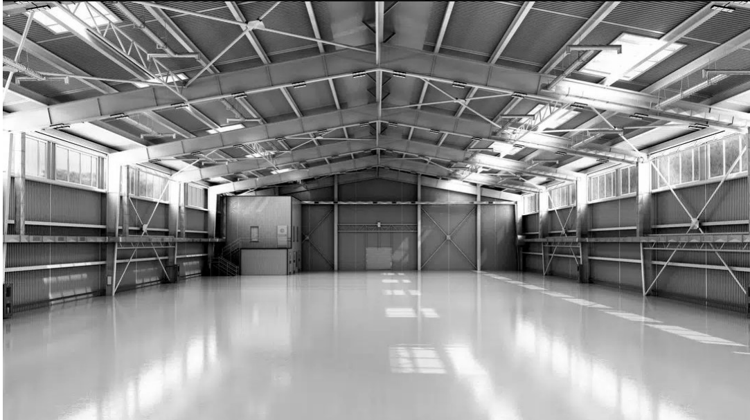
Figura 1 - Pórticos de perfis com alma cheia
