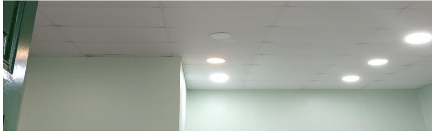
Figura 10 - Forro de fibra mineral localizado no posto central
