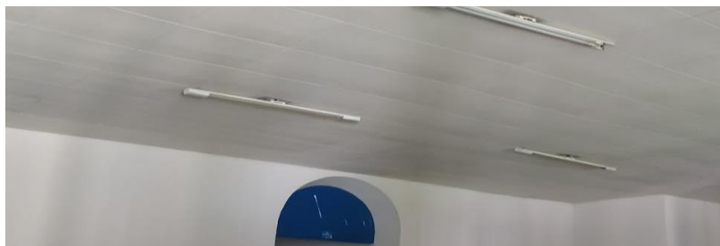
Figura 9 - Forro de PVC localizado em uma enfermaria
