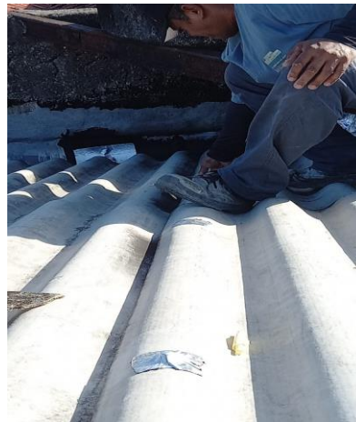
Figura 11 - Manta fria colocada na rachadura na telha e beiral
