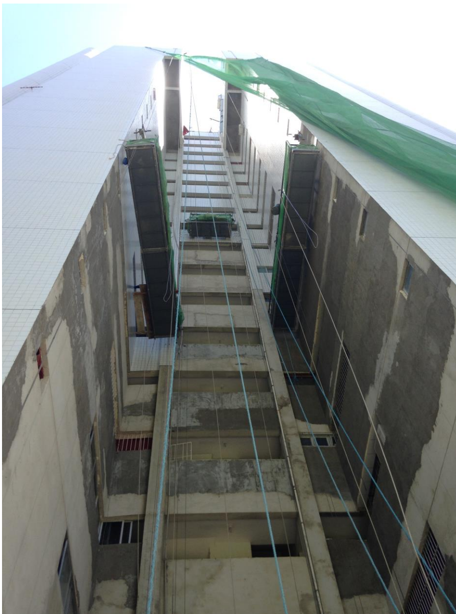
Figura 2– Aplicação de cerâmica com andaimes suspensos no recuo da fachada posterior.
