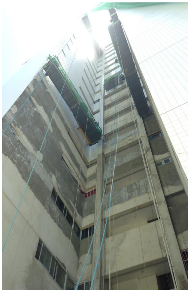
Figura 8 – Disposição dos andaimes suspensos.
