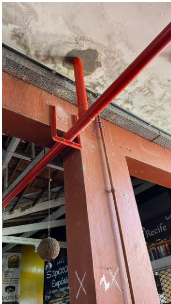
FIGURA 19- Pilar e viga.
