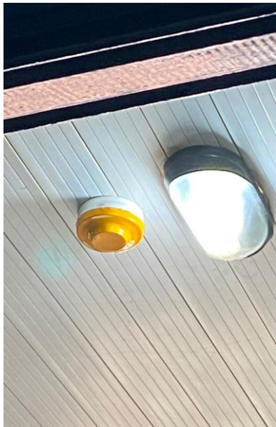
FIGURAS 16 - Detectores de fumaça obstruídos e quebrados.
