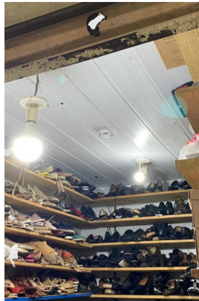
FIGURAS 16 - Detectores de fumaça obstruídos e quebrados.
