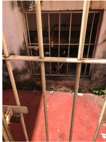
Casa de bombas
