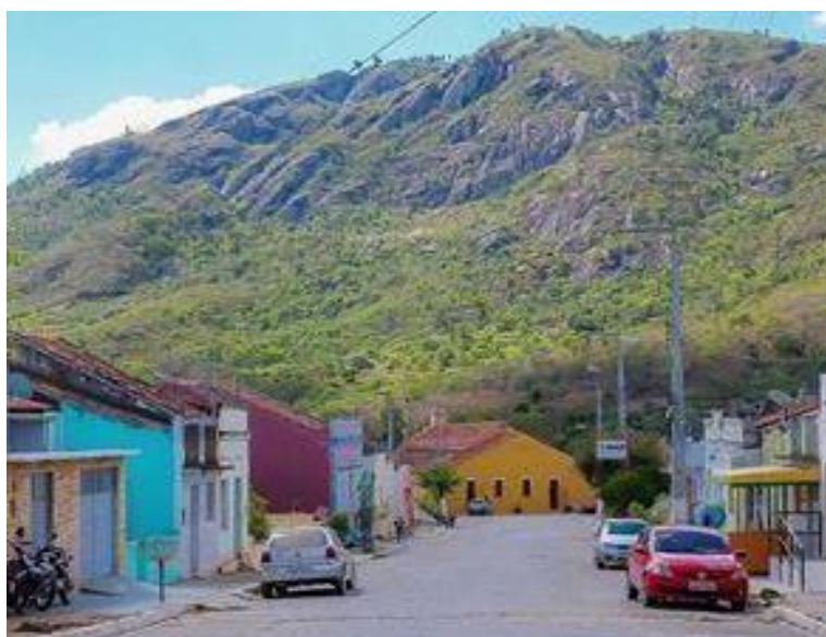
Figura 2 - Aspecto do Brejo da Serra do Vento, Belo Jardim-PE.
