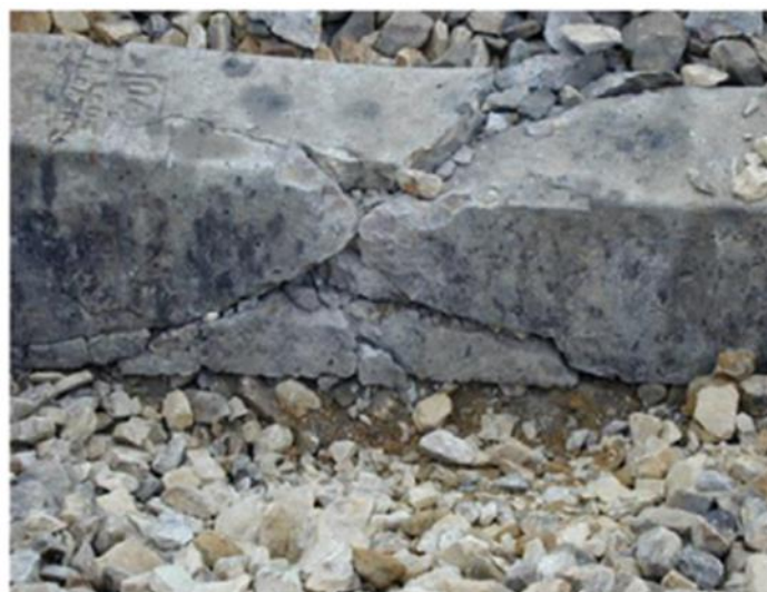
Figura 34 – Dormente rompido em sua seção central
