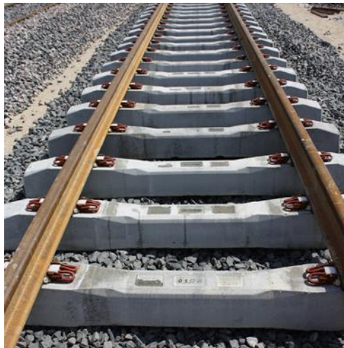
Figura 11 – Dormente de concreto protendido
