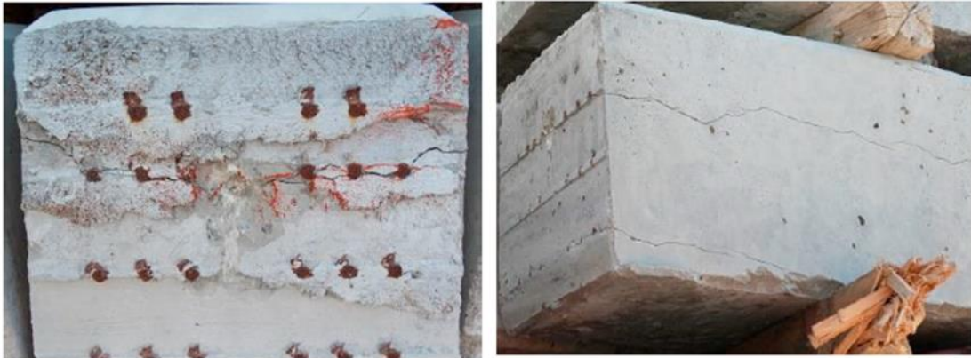
Figura 23 – Exemplo de dormentes fissurados pouco tempo após fabricação
