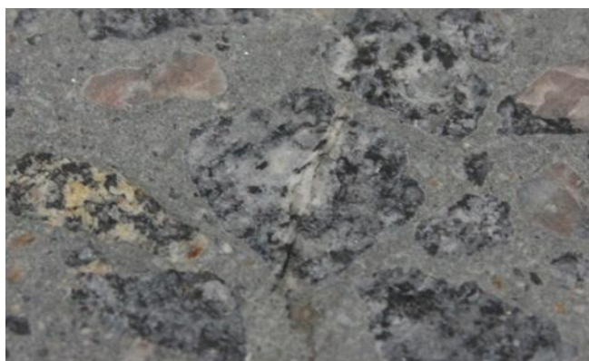
Figura 52 – Detalhe da fissura que passa pelo agregado gráúdo indicada na foto 47
