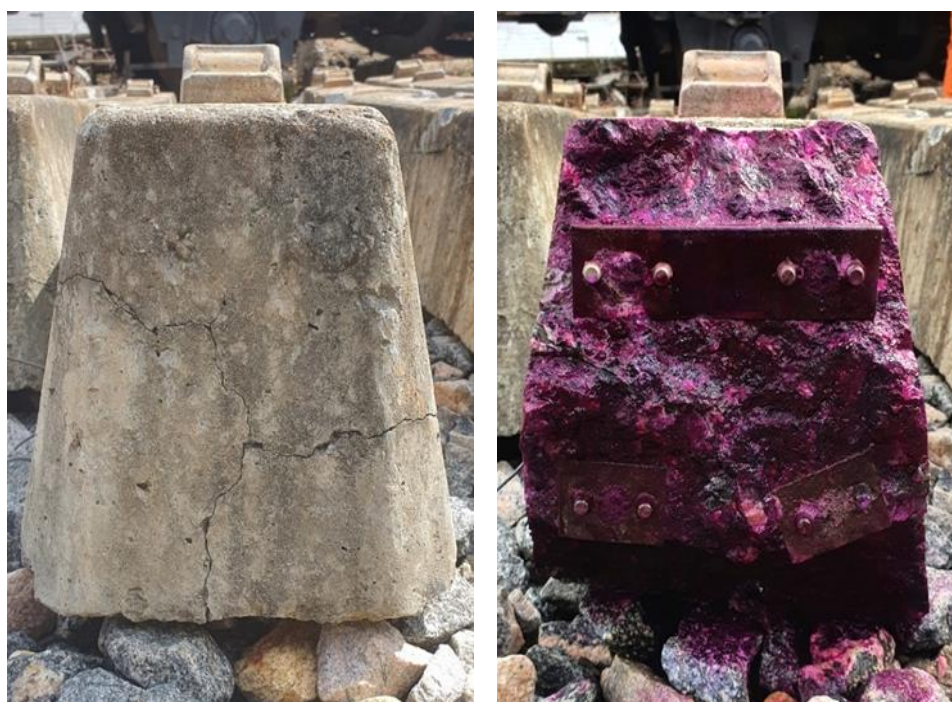
Figura 61 – Ensaio de carbonatação na extremidade do dormente nº 03
