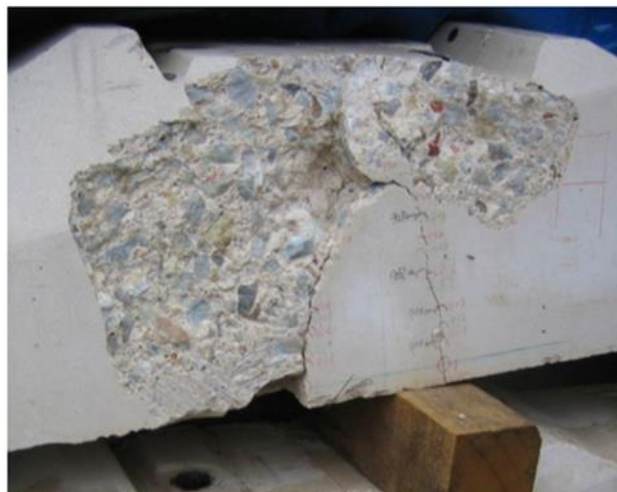
Figura 21 – Diferença da distribuição dos agregados ao longo da seção do dormente
