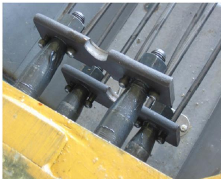
Figura 20 – Placas de ancoragem de protensão
