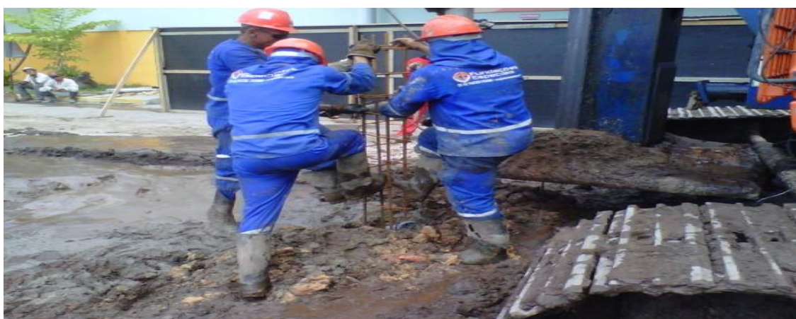
Figura 13 - Colocação da armadura após a retirada do trado, onde a mesma é inserida por gravidade com auxílio de ajudantes.
