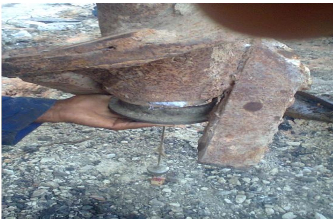
Figura 10 – Locação da estaca no ponto determinado pela topografia. A haste de perfuração é constituída da hélice espiral, tubo central e os dentes da extremidade responsável pela retirada de solo e um tubo.
