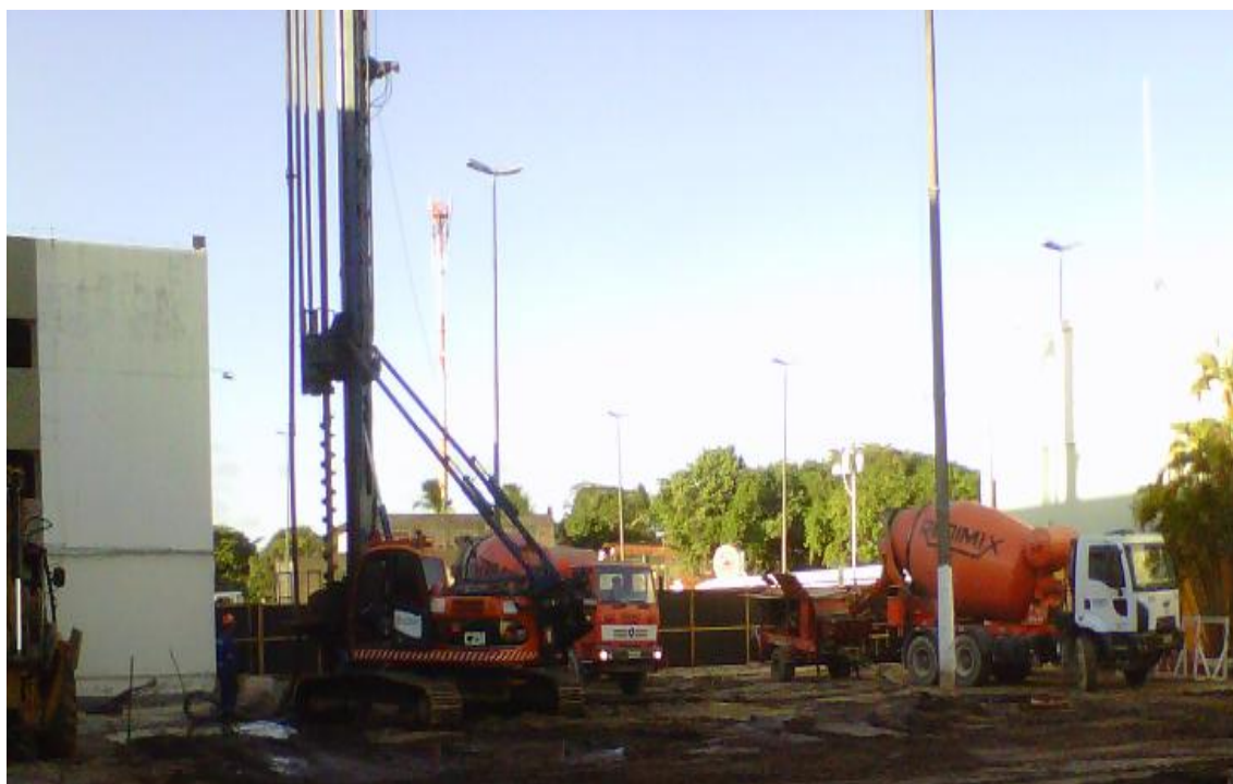
Figura 11 – Injeção de concreto no furo da estaca, através do fornecimento do concreto do caminhão betoneira, bomba estacionária e injeção no furo sobre pressão positiva. À esquerda, uma retroescavadeira, que juntamente com os
