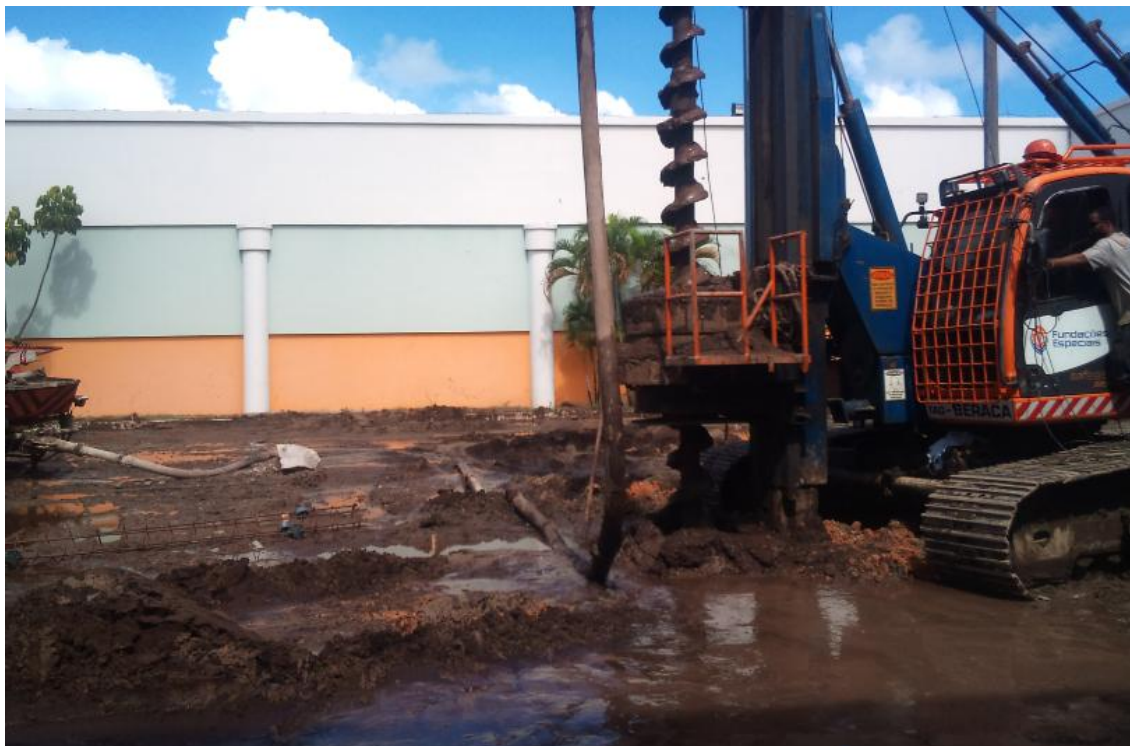
Figura 9 – Perfuração do terreno (obra estudada).
