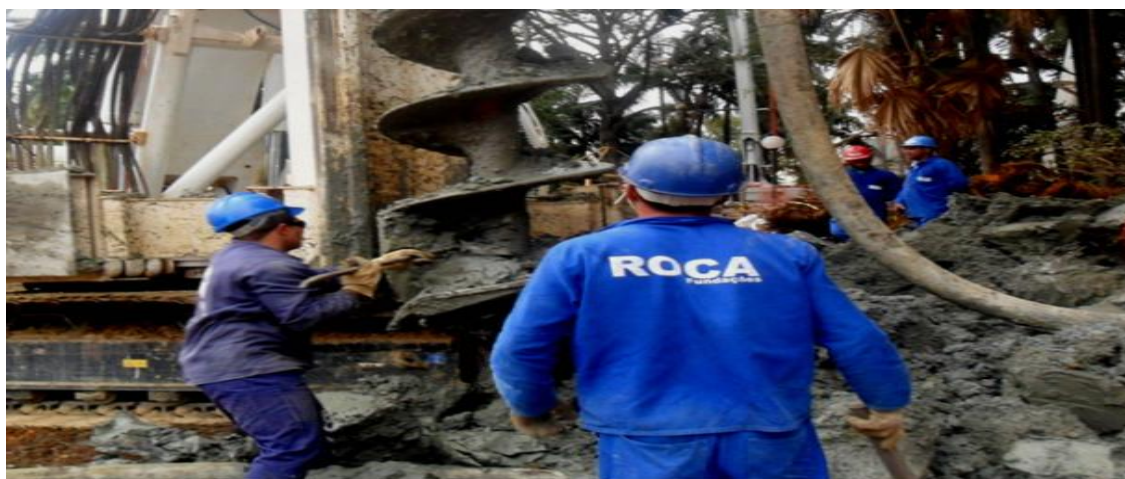
Figura 12 - Limpeza da hélice de forma manual com a retirada do solo entre as pás da hélice
