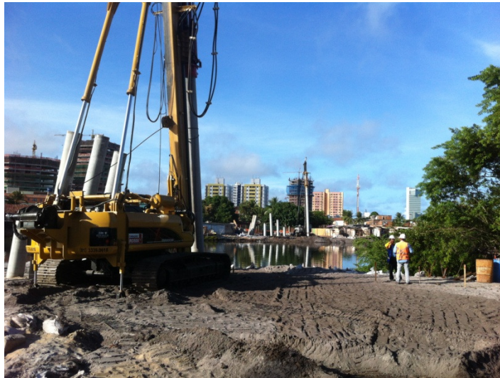
Figura 4. Cravação das estacas P20 e P30
