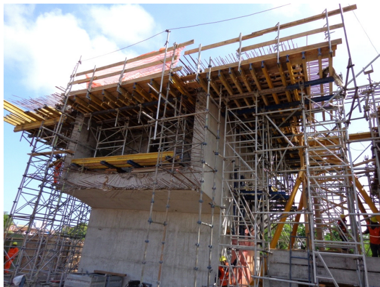
Figura 8. Detalhe do escoramento do arranque do P30
