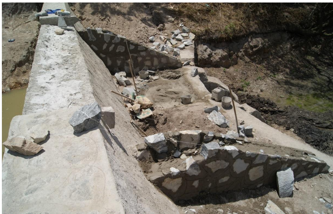
Figura 12: Detalhe da junção da barragem nova com barragem existente à jusante ambas em alvenaria de pedra
