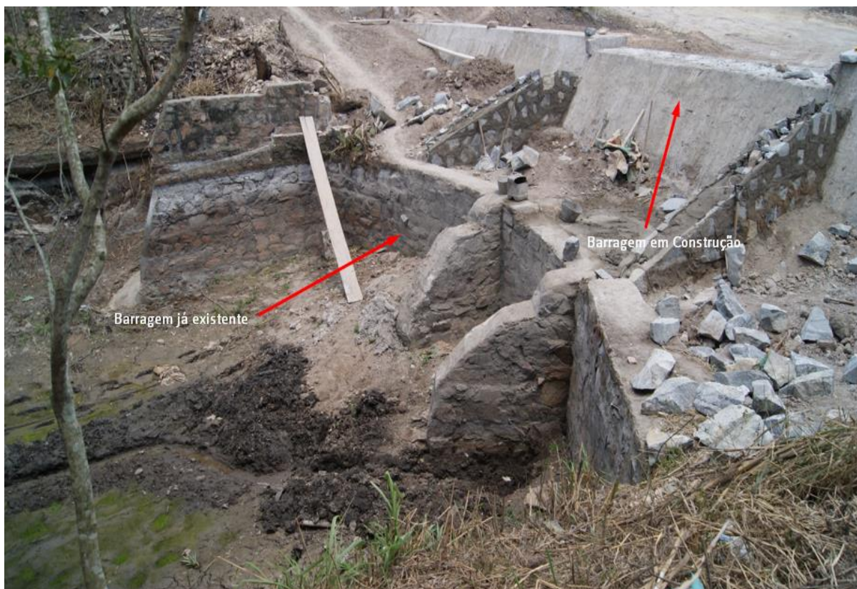
Figura 13: Foto de outra perspectiva da junção das barragens Existente e Nova.
