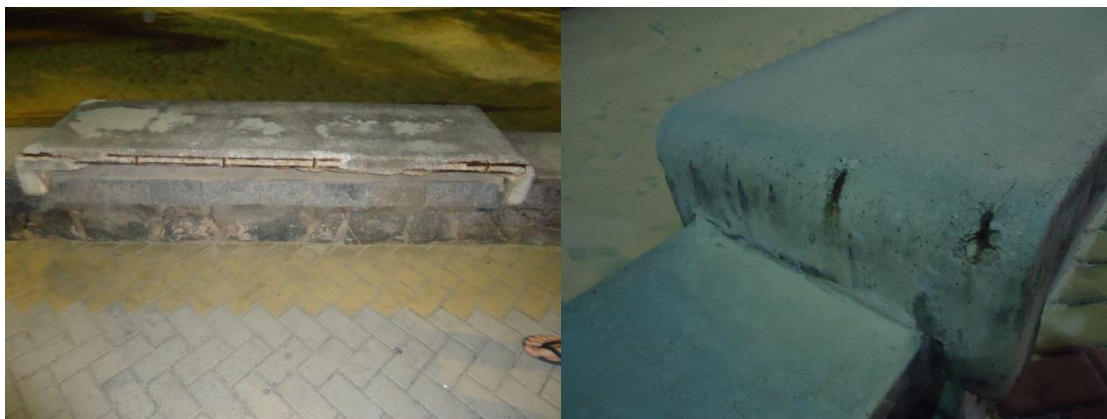
Figura 5.1: Patologias nos bancos - trecho A
