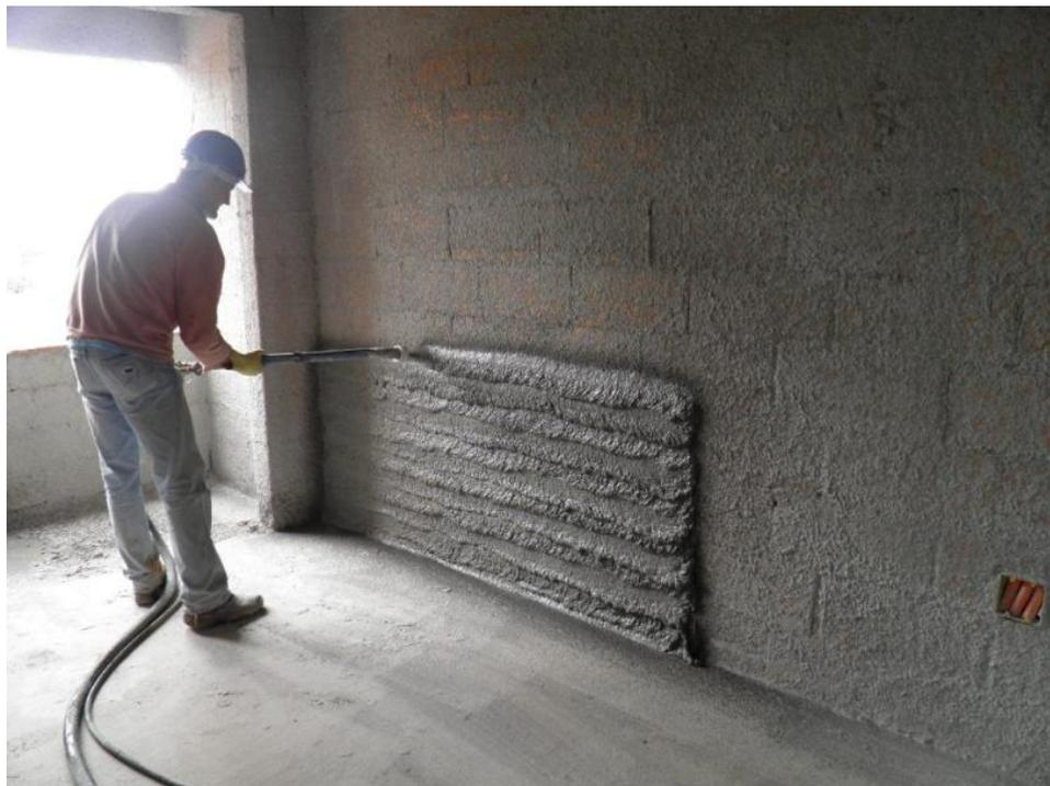
Figura 5 – execução do reboco projetado.
