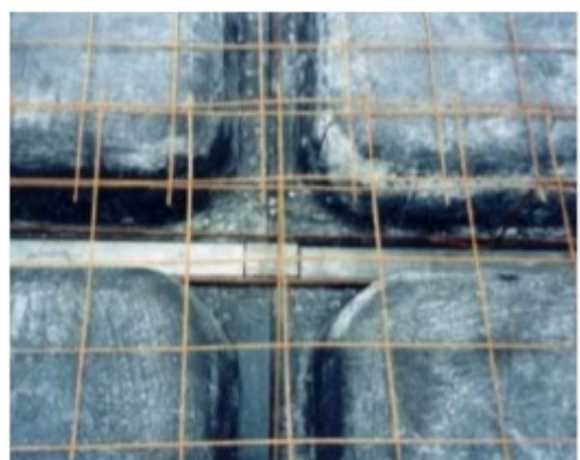
Figura 17 – Armadura de Distribuição de uma Mesa. (www.atex.com.br)
