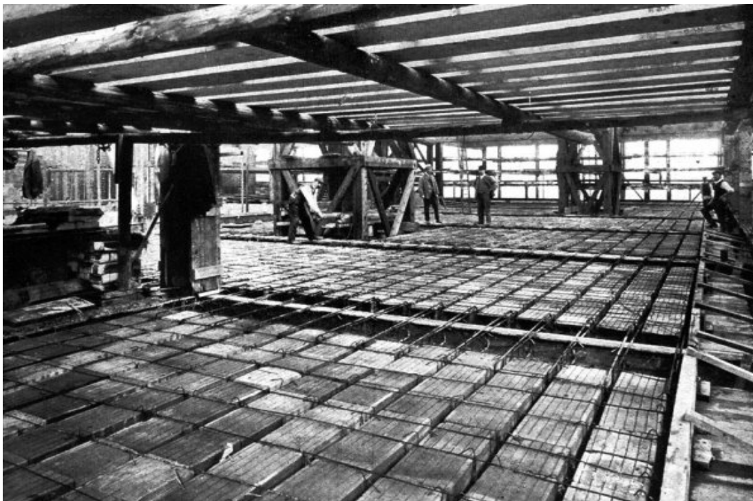
Figura 3 – Lajes nervuradas de concreto armado, compostas por blocos cerâmicos entre nervuras. (Concrete and Constructional Engineering, Nov. 1913, Vol. III)
