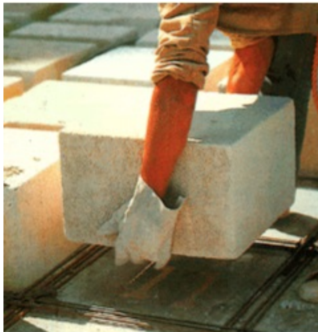
Figura 14 – Bloco Celular Como Material de Enchimento da Laje. (UFMG, Departamento de Engenharia Civil)
