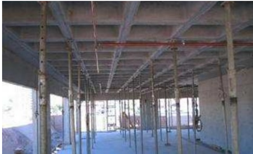
Figura 21 – Emprego de Laje Nervurada de Concreto Armado. ( www.atex.com.br )
