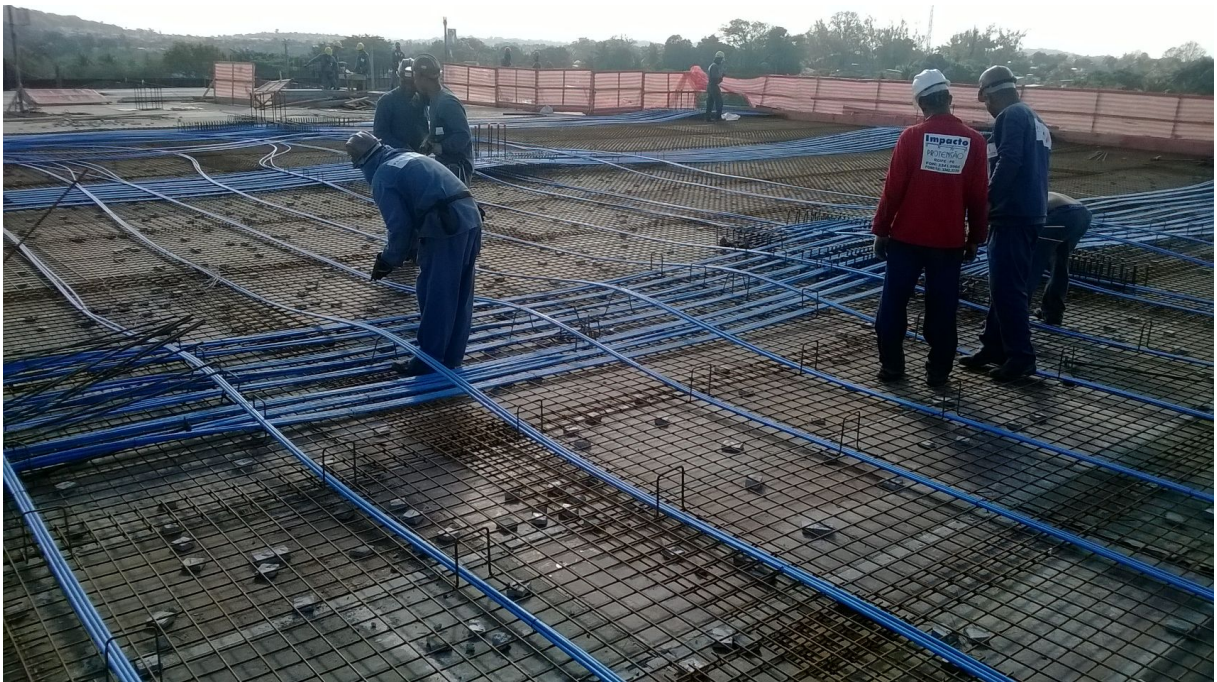
Figura 45 – Vista Geral do Pavimento de Laje Lisa Protendida Pré-concretagem.
