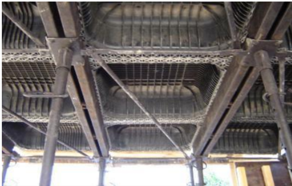
Figura 12 – Escoramento Metálico. (Universidade Feevale, Departamento de Arquitetura)
