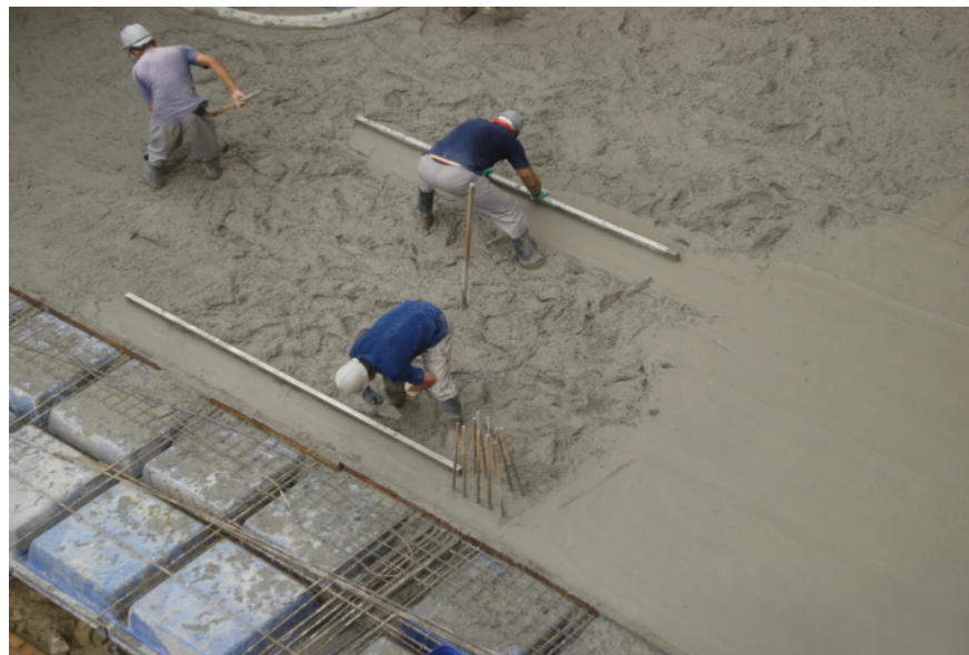
Figura 18 – Concretagem de Laje Nervurada. ( www.ufrgs.br )
