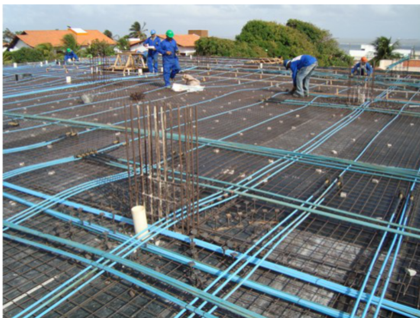
Figura 38 – Aplicação da Armação Ativa. ( www.gaussprotensão.com.br )
