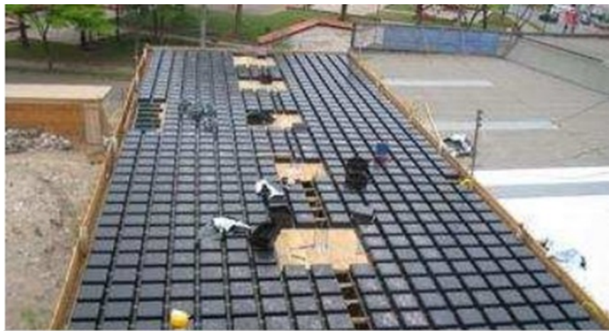
Figura 22 – Emprego de Laje Nervurada de Concreto Armado. ( www.arcoweb.com.br )
