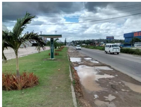
Figura 7: Sistema de drenagem Ineficaz
