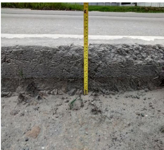
Figura 32 – Espessura das placas Fonte: Autores
