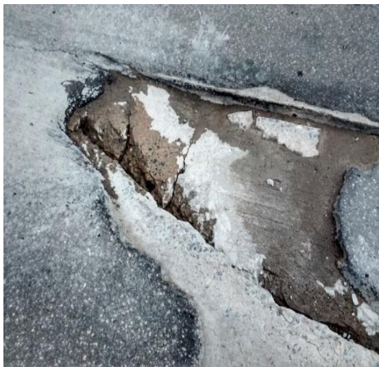
Figura 21: Quebras localizadas Fonte: Autores
