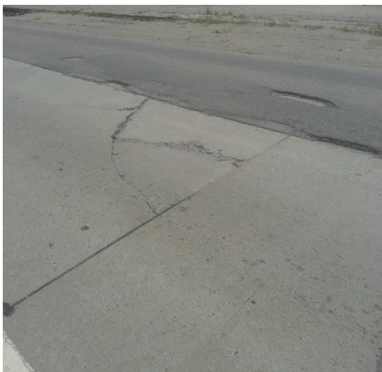
Figura 18: Fissura de Canto Fonte: Autores
