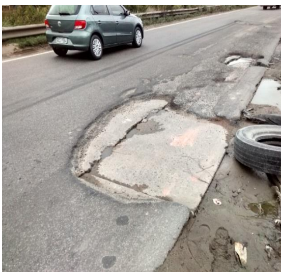
Figura 20: Fissura linear longitudinal Fonte: Autores
