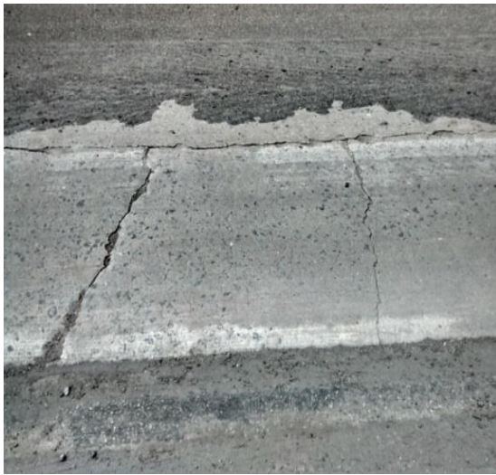
Figura 24: Fissura linear transversal Fonte: Autores
