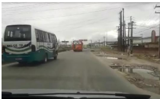
Figura 8: Sistema de drenagem Ineficaz
