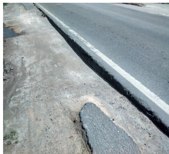
Figura 22: Desnível Pavimento–Acostamento Fonte: Autores
