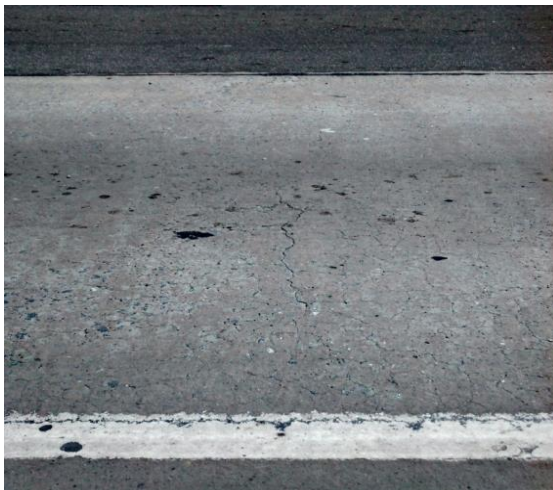
Figura 27 – Fissuras superficiais Fonte: Autores
