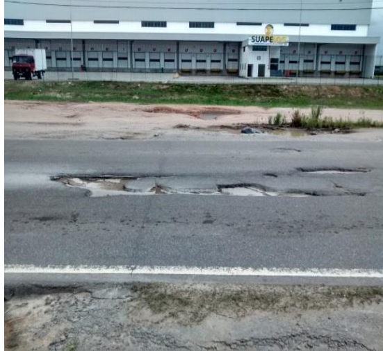
Figura 31: Danos na via ap s recapeamento Fonte: Autores
