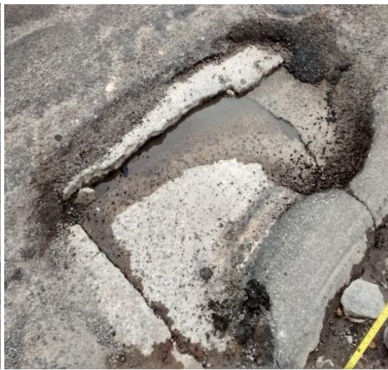
Figura 25: Alçamento de placas Fonte: Autores
