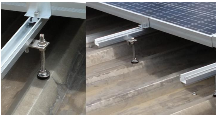
Figura 21 - Suporte para instalação da placa solar sobre a telha metálica
