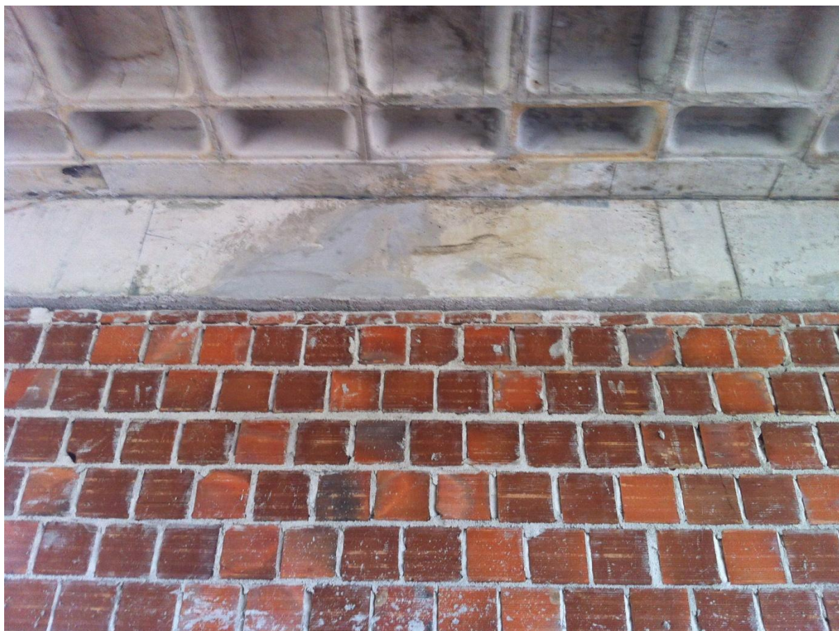
Figura 22 - Encunhamento da parede alvenaria com meios blocos. Fonte: Arquivo pessoal.
