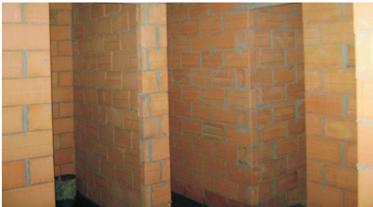
Figura 3 - Paredes em alvenaria de Blocos Cerâmicos. Fonte: Thomaz et al.,2009
