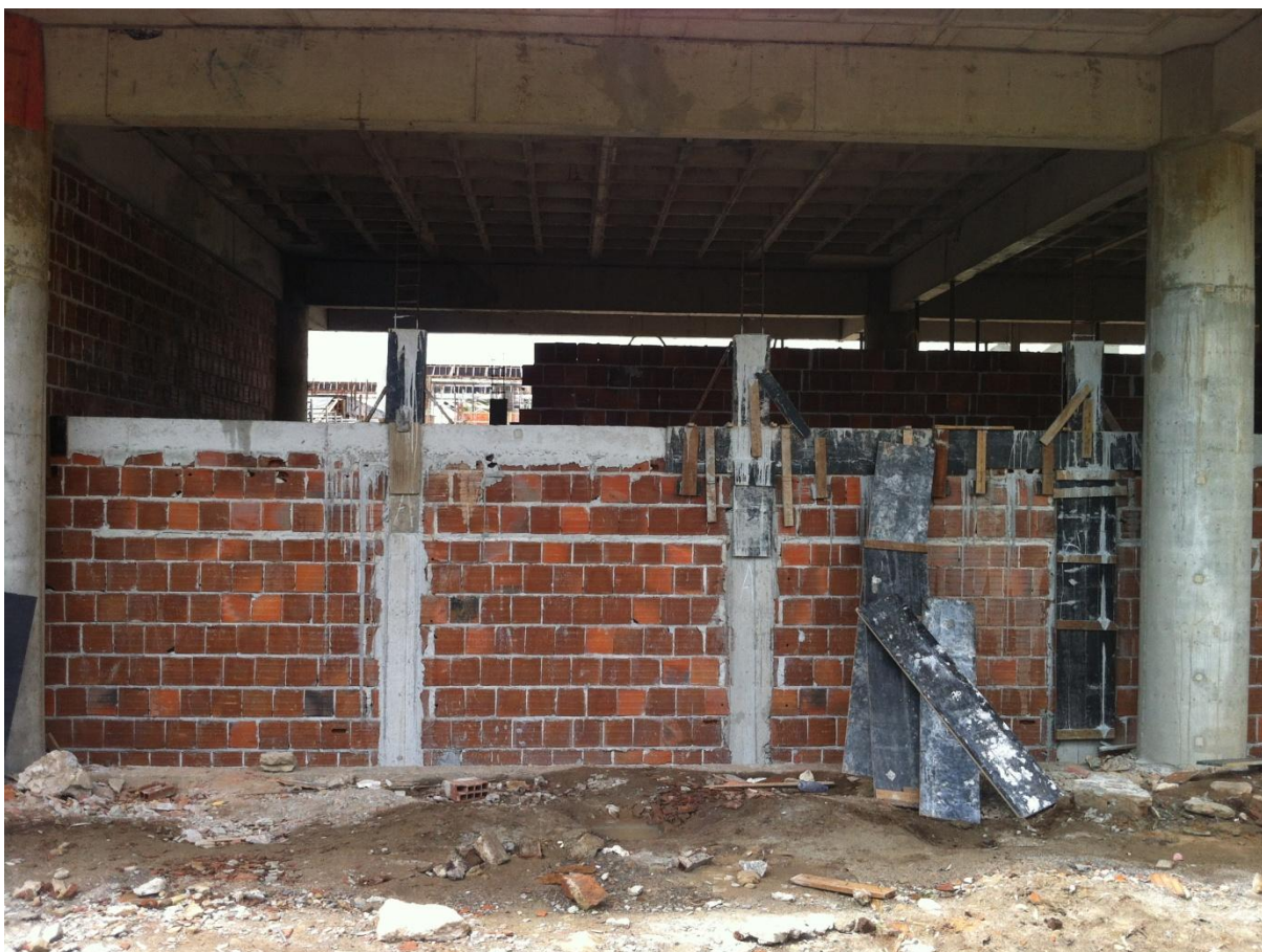
Figura 7 - Foto de uma parede limitada por viga e pilares. Fonte: Arquivo pessoal.
