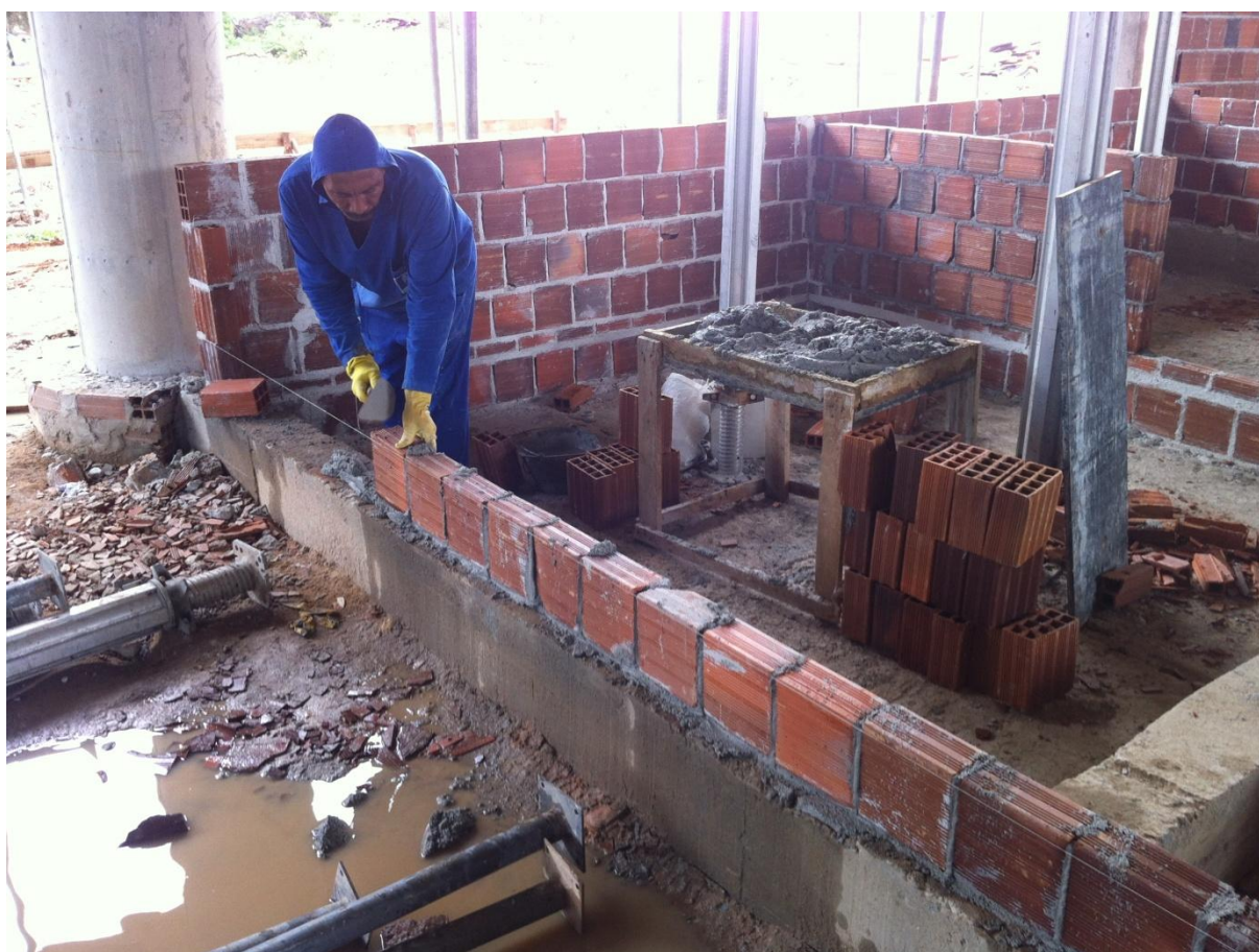
Figura 5 - Elevação de parede de alvenaria em blocos cerâmicos de 8 furos e argamassa de assentamento. Fonte: Arquivo pessoal.
