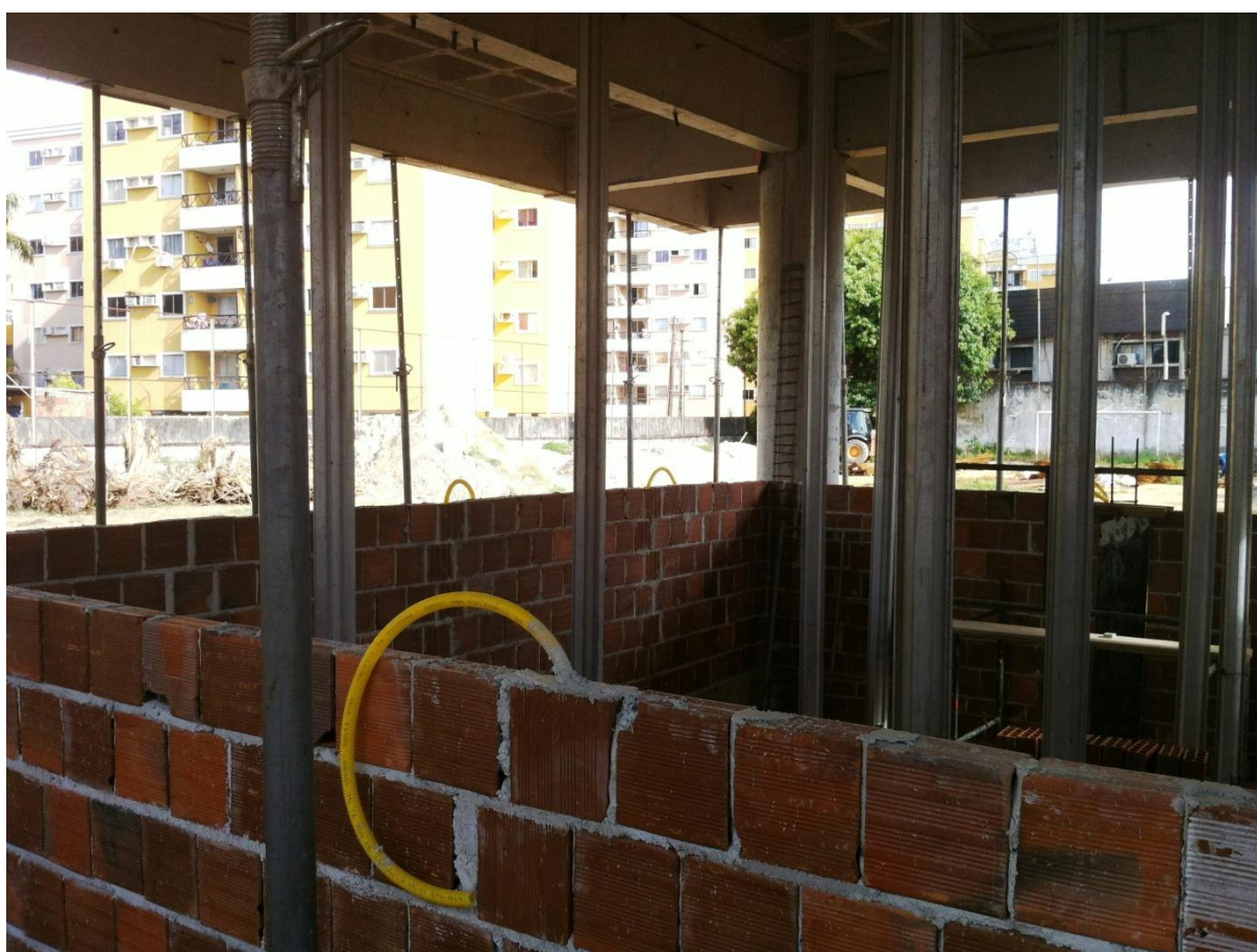
Figura 8 - Caminhamento dos eletrodutos pelos furos da alvenaria. Fonte: Arquivo pessoal.
