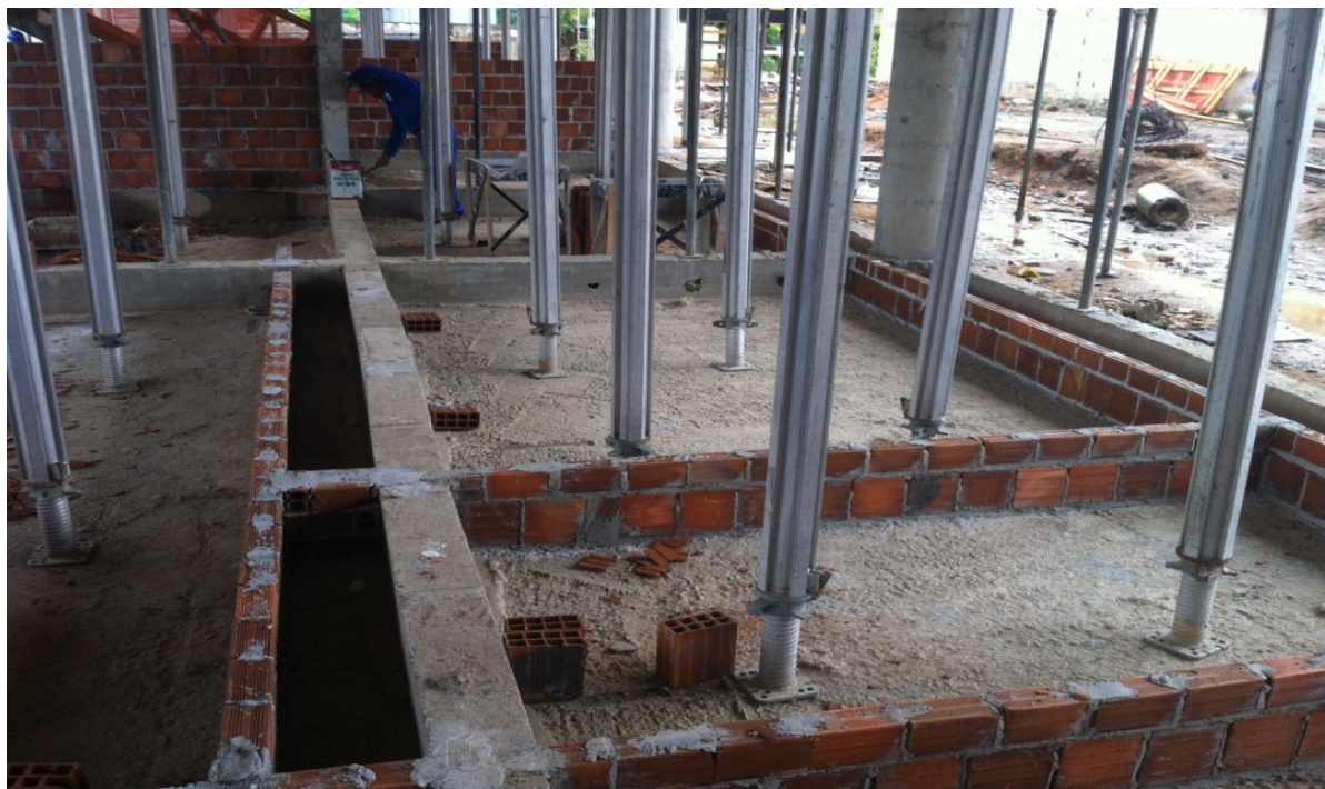
Figura 11 - Marcação da Primeira fiada. Fonte: Arquivo Pessoal.
