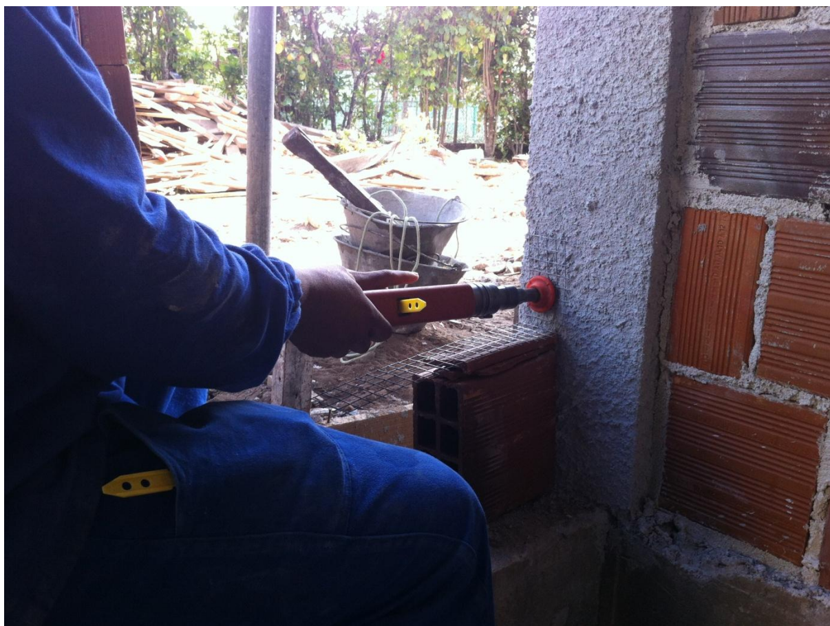
Figura 18 - Fixação da alvenaria na estrutura com tela de aço galvanizado. Fonte: Arquivo Pessoal.
