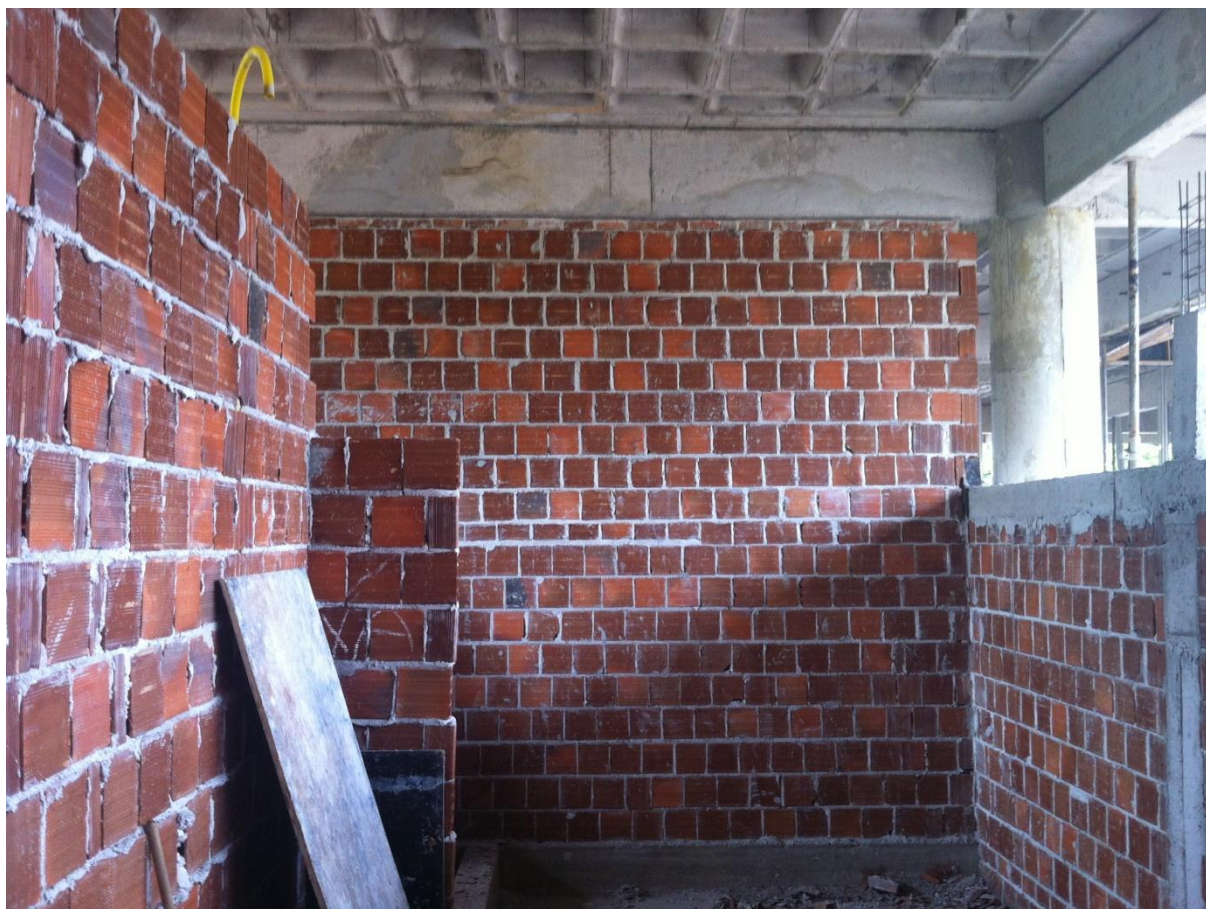
Figura 9 - Parede em alvenaria de blocos cerâmicos com as juntas defasadas. Fonte: Arquivo Pessoal.
