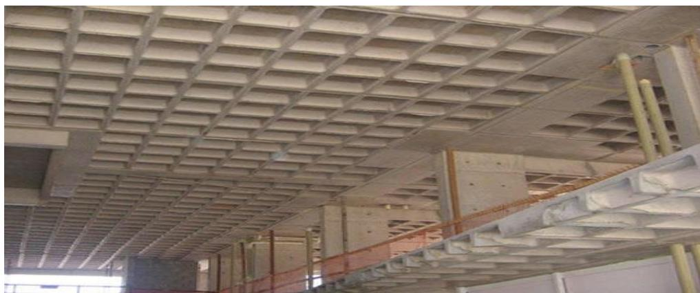
Figura 4: Foto de Laje Nervurada
