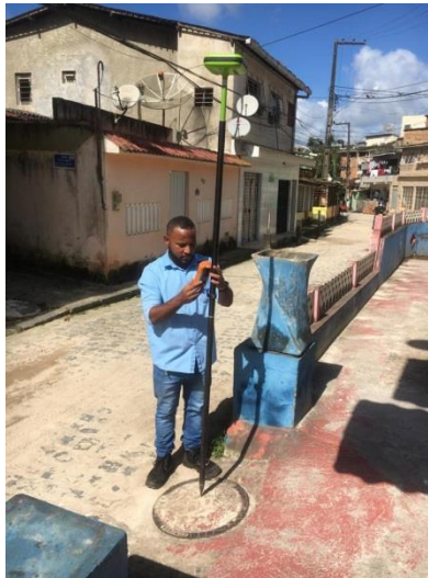
Figura 42: Coleta da cota de Tampo do Poço de Visita
