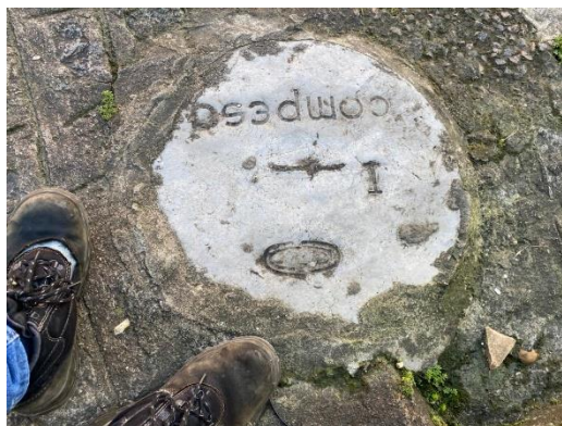
Figura 35: Caixa Lacrada com cimento
