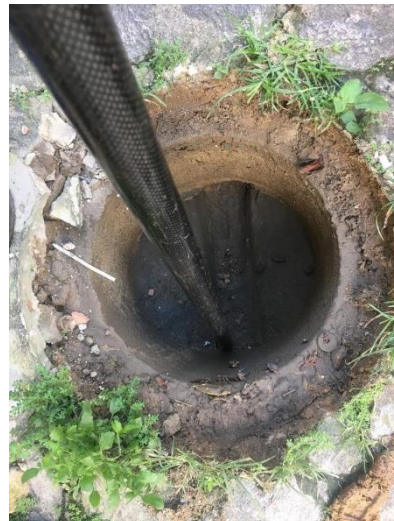
Figura 40 e 41: Coleta da profundidade da Caixa
