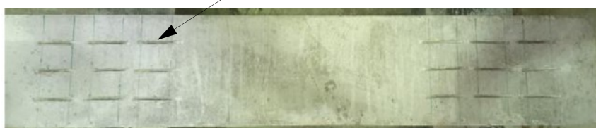
Figura 9 – Ranhuras no concreto para aderência CFRP-concreto Ranhuras de 50 mm x 10 mm (largura x profundidade) Espaçamento a cada 50 mm
