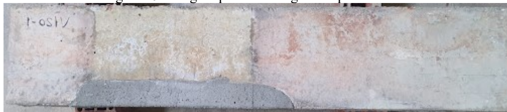
Figura 29 – Viga reparada com graute após incêndio
