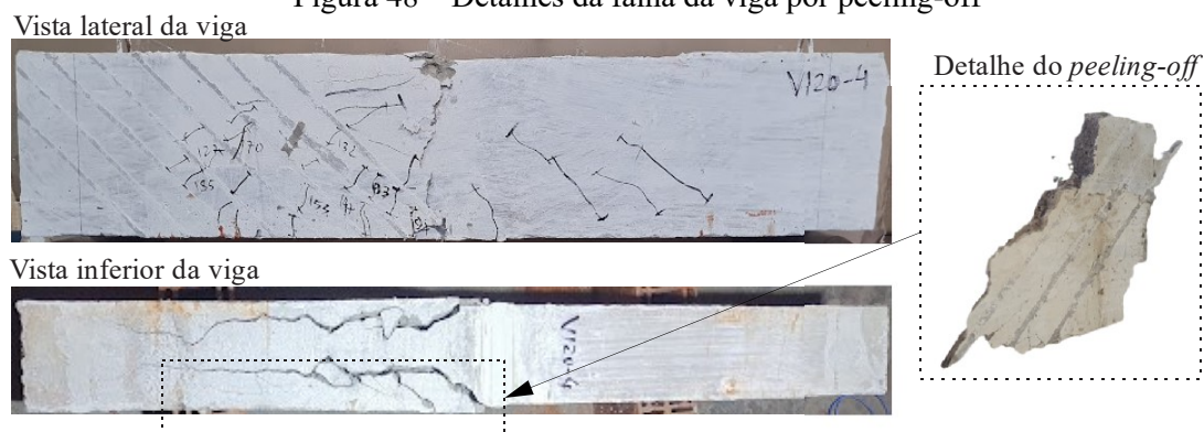
Figura 48 – Detalhes da falha da viga por peeling-off
