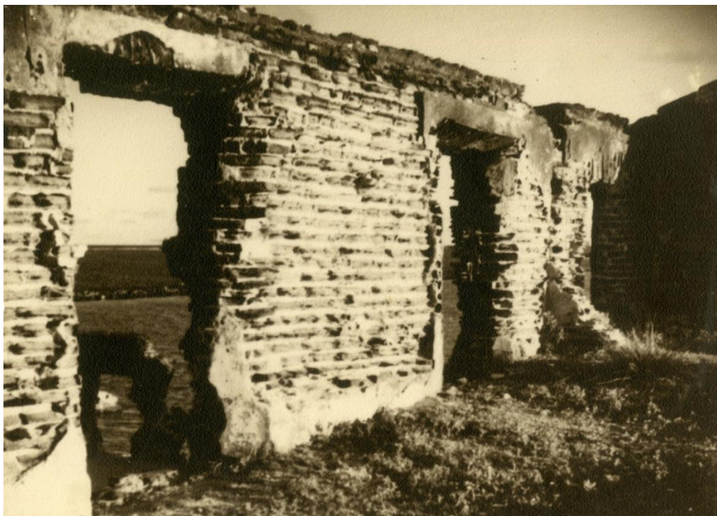
Fig. 35. Paredes internas do sobrado do comandante em 1939.
