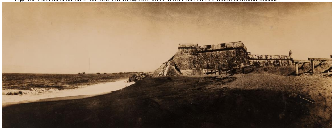
Fig. 43. Vista do setor norte do forte em 1912, com meio-vértice ao centro e muralha desmoronada.
