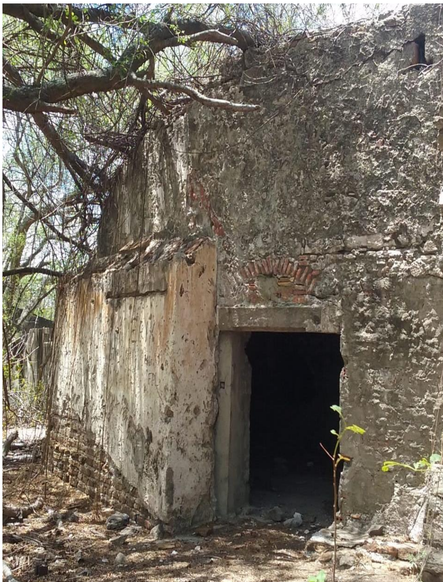
Fig. 25. Momentos construtivos na entrada da antiga Cadeia.
