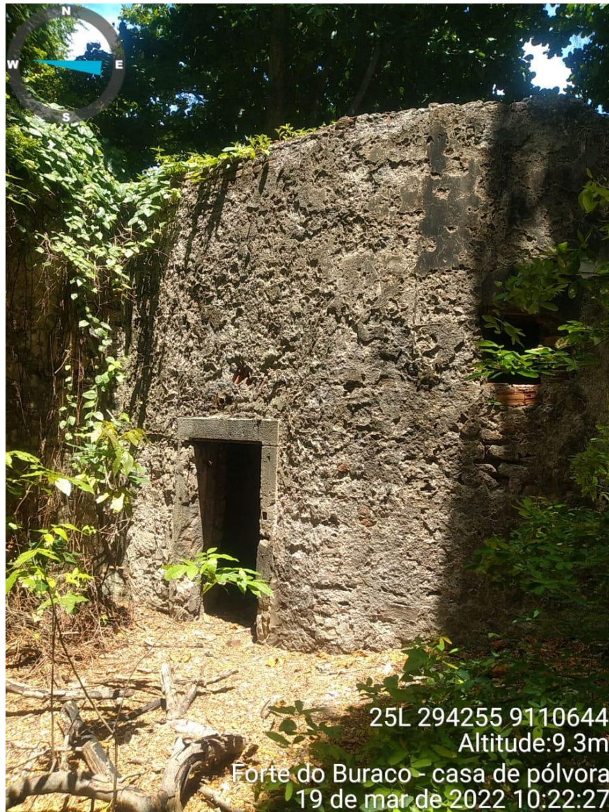
Fig. 27. Face externa da Casa de Pólvora com vegetação circundante e ausência de revestimento.
