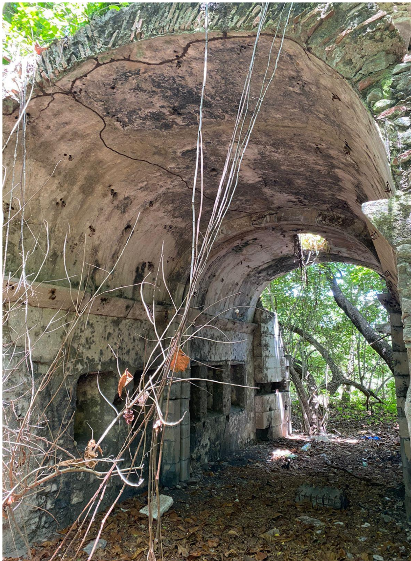
Fig. 19. Aspecto interno do arco de entrada.
