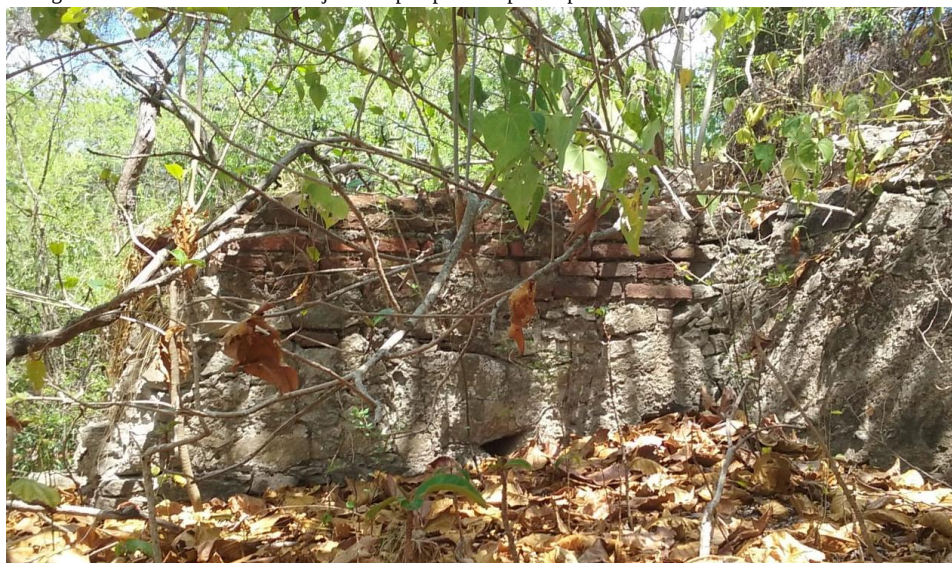
Fig. 37. Trecho em alvenaria de tijolos do parapeito no piso superior do forte
