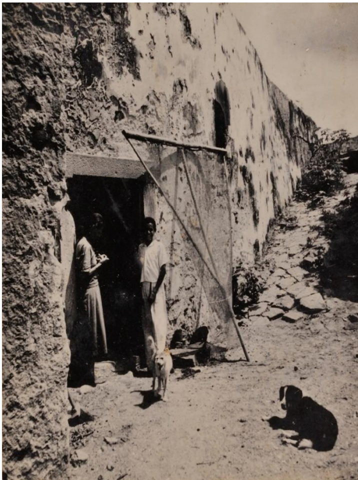
Fig. 61. Estrutura da Casa de Pólvora servindo de moradia nos anos 1940.
