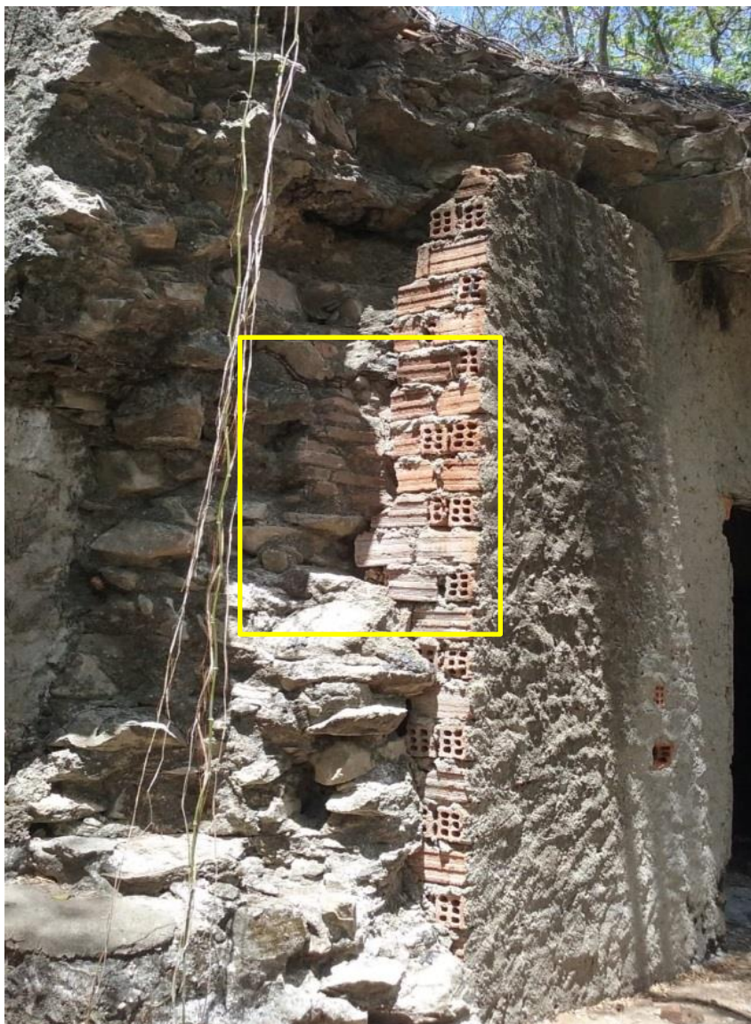
Fig. 24. Em destaque, a sobreposição construtiva na entrada da Casa de Artilharia.
