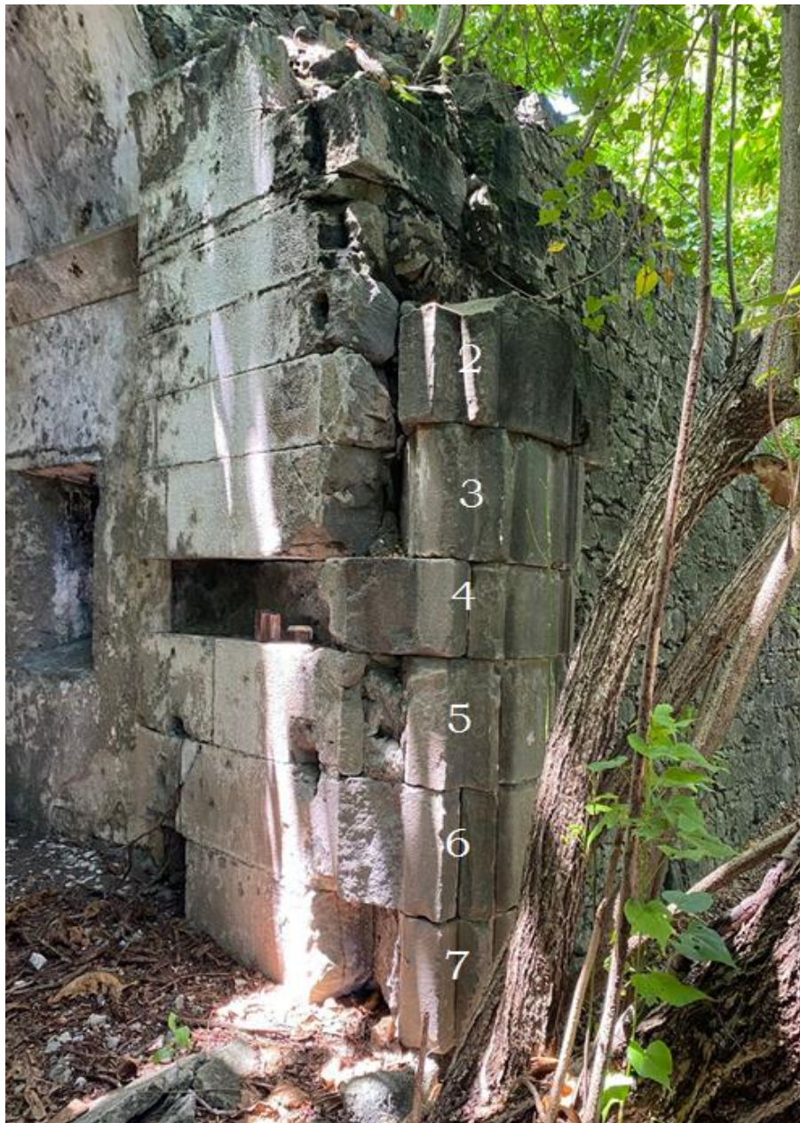
Fig. 13. Face lateral da coluna em blocos na entrada do forte.
