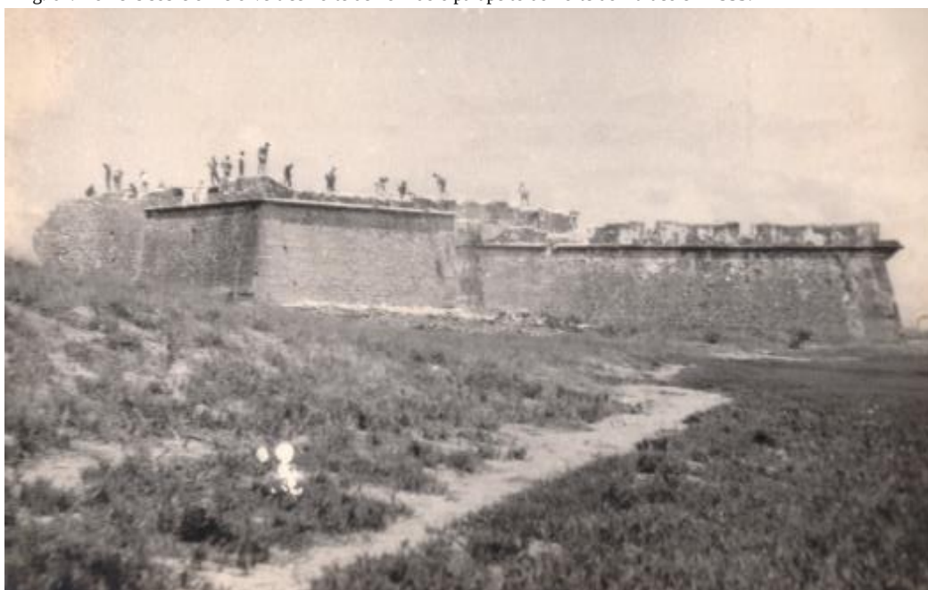
Fig. 64. Homens sobre o meio-vértice norte demolindo o parapeito do Forte do Buraco em 1953.
