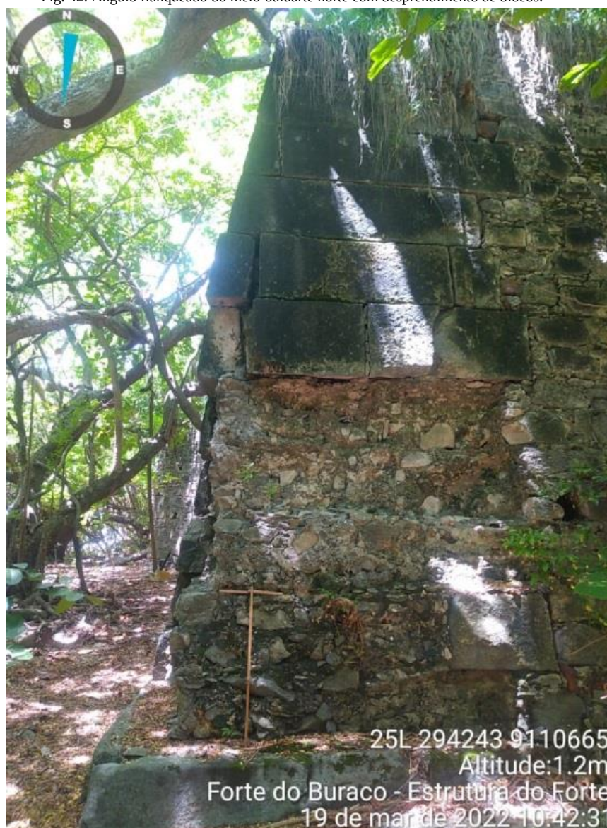
Fig. 42. Ângulo flanqueado do meio-baluarte norte com desprendimento de blocos.
