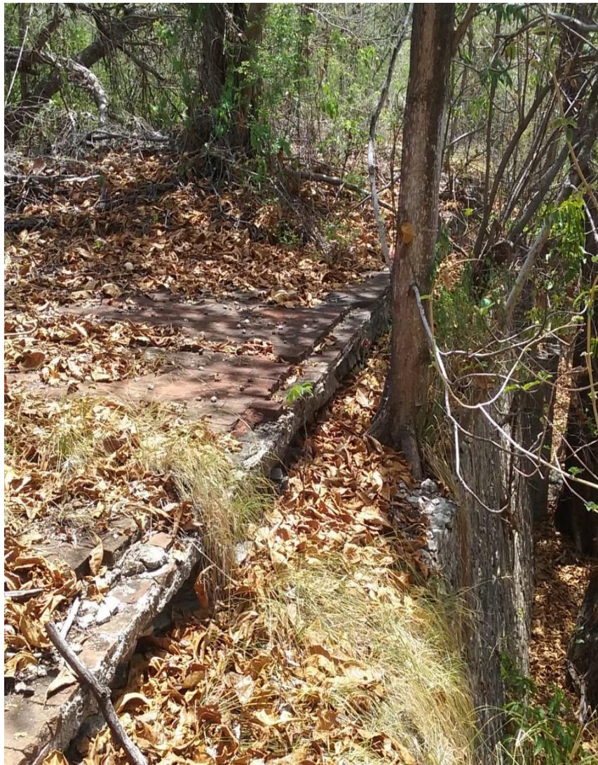
Fig. 36. Pavimento superior com árvores ocupando o lugar do antigo sobrado e do parapeito.
