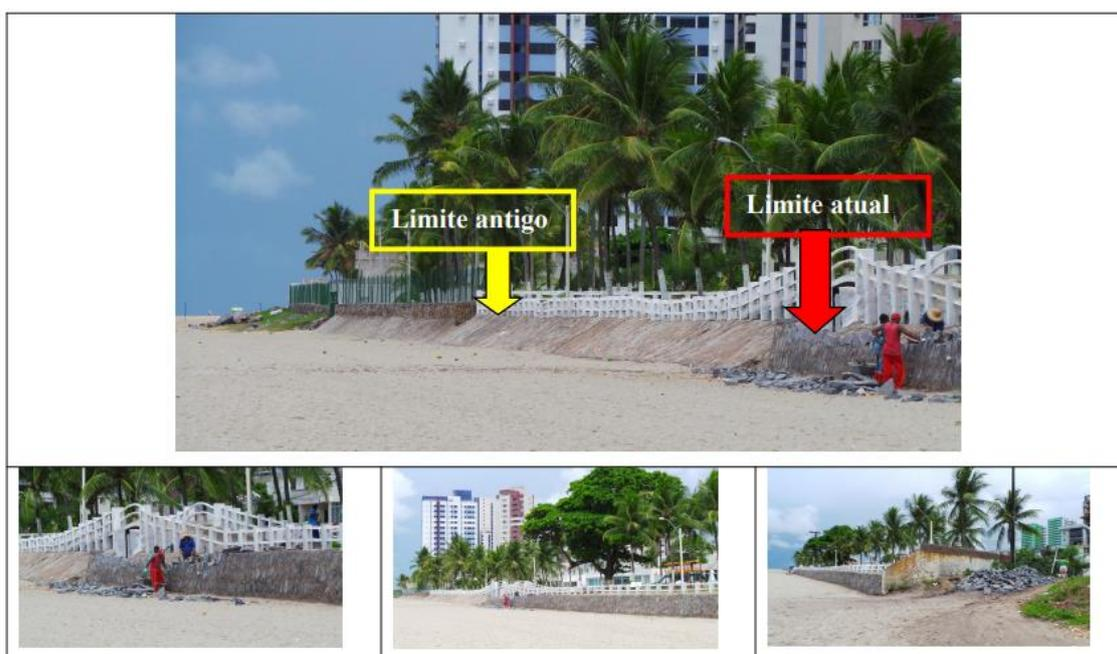
Figura 6.9.2.1. Registros da construção do muro do Residencial Candeias sobre a pós praia reconstituída pelo aterro hidráulico, sem haver, entretanto, autorização para construção (Fonte: NEM, 2019).
