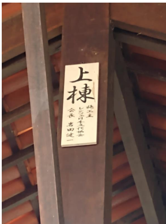
Figura 05 – Placa no pilar central da sede da ACJR
