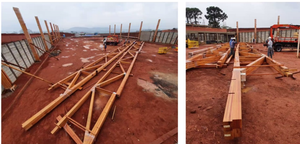
Figura 3.23. Canteiro de obras e finalização da montagem da viga treliçada in situ. Fonte: João Pini, ITA Construtora.
