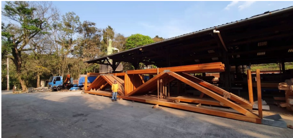
Figura 3.22. Montagem da viga treliçada ainda em fábrica. Fonte: João Pini, ITA Construtora.
