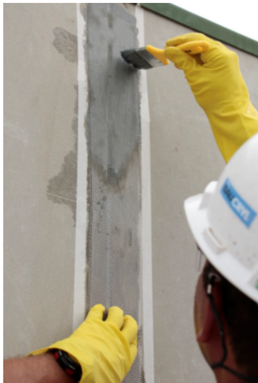
Figura 9 - Tratamento de juntas
