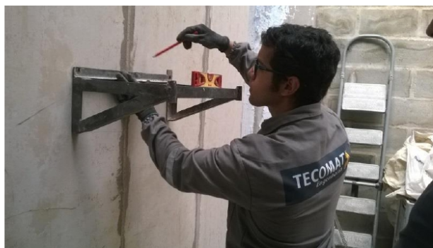
Figura 5 – Fixação da mão-francesa e o carregamento
