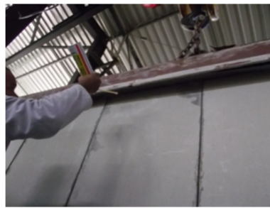
Foto 2 - Vedação da junta superior com espuma expansiva de PU
