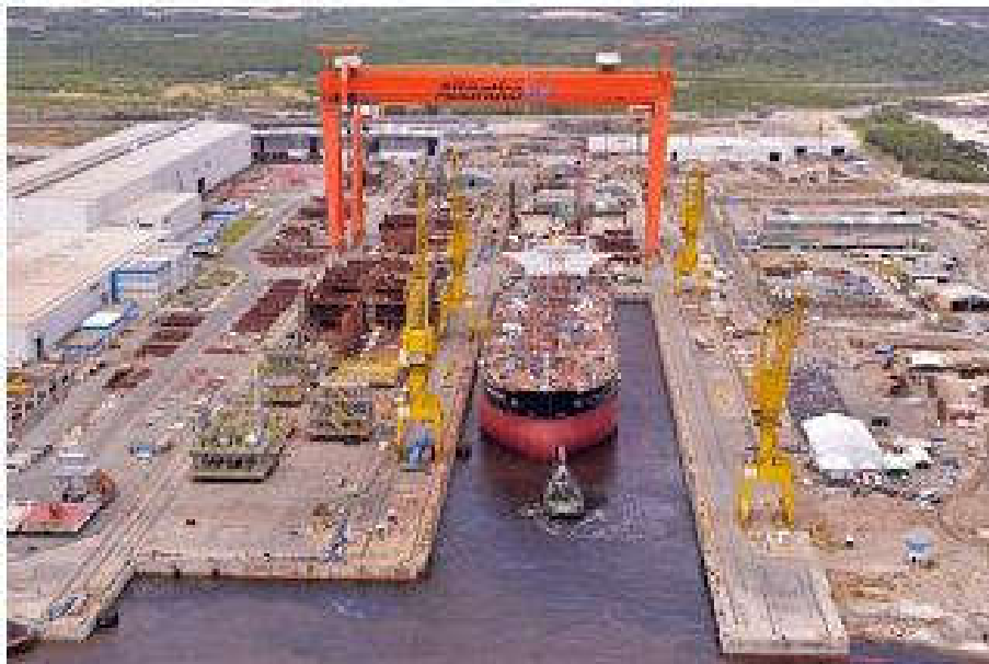
Figura 2: Lançamento de navio cujo berço de construção foi o dique seco.
