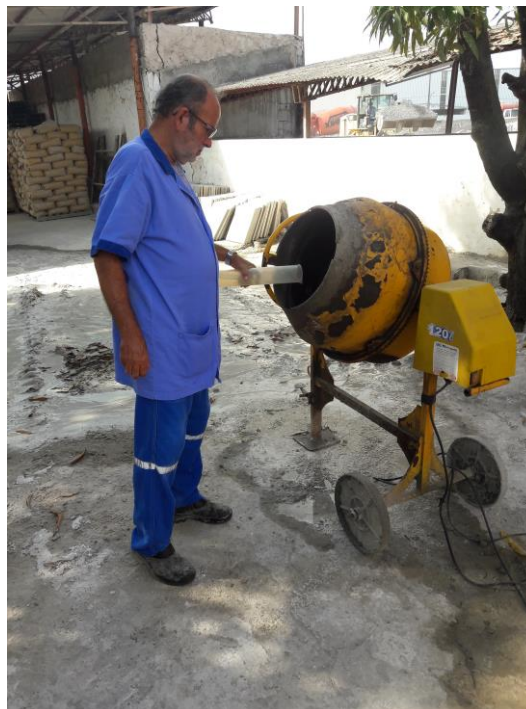
Figura 8 – Colocação da água/aditivo na mistura cimento/agregado
