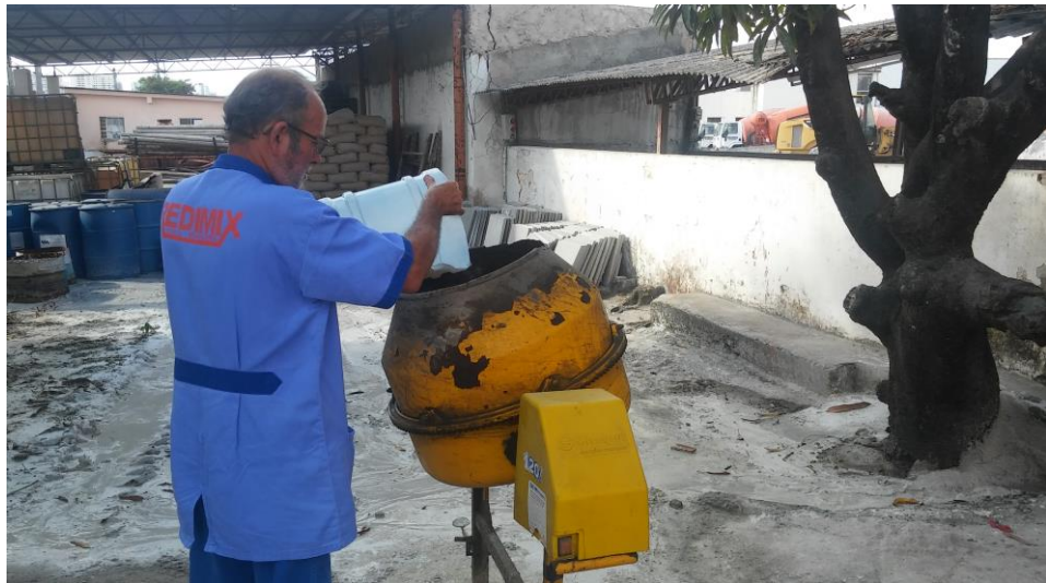
Figura 7 - Adição da água/aditivo na mistura cimento/agregado.
