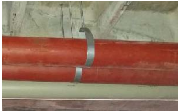
Figura 30 - Suporte da tubulação.
