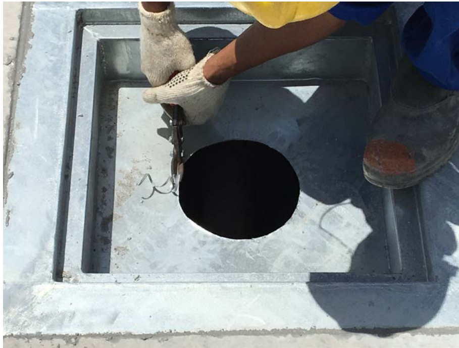
Figura 39 - Alargamento da caixa metálica.
