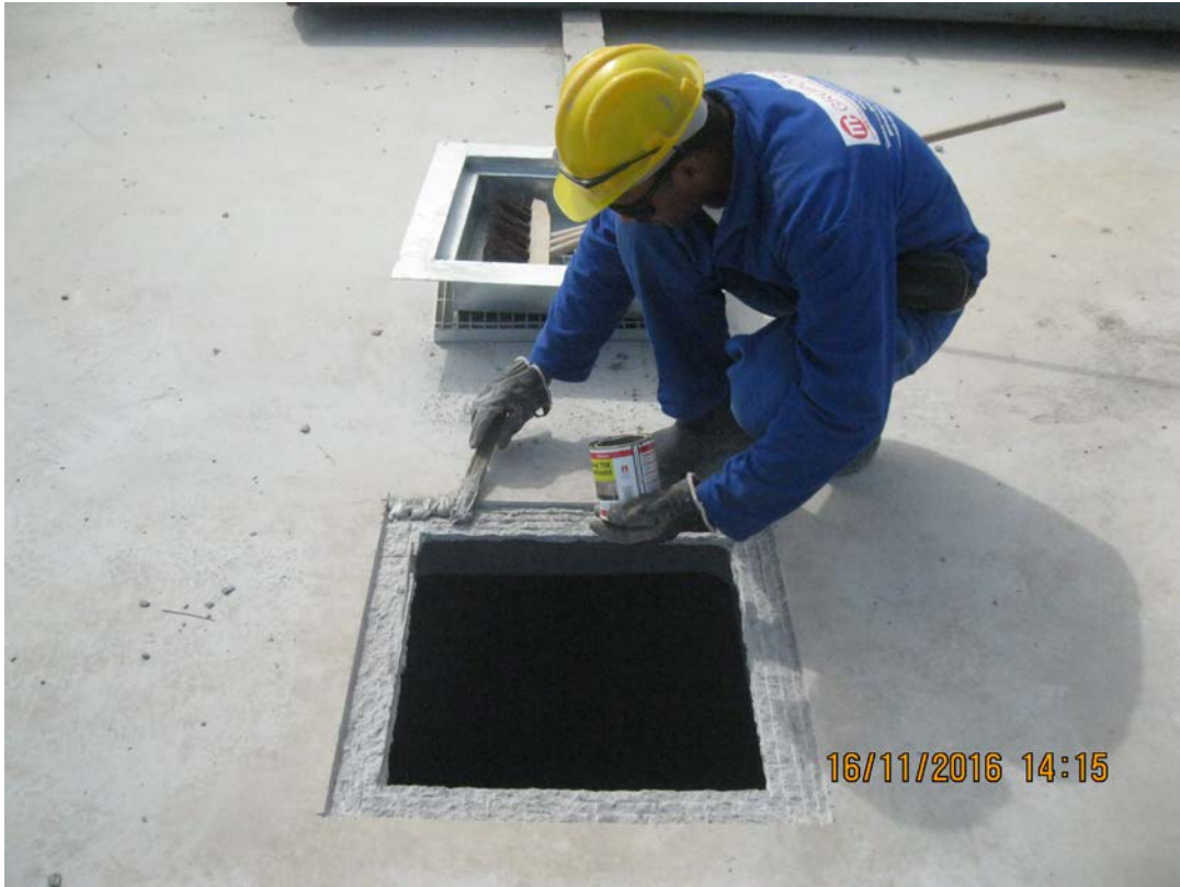
Figura 38 - Aplicação do adesivo estrutural tixotrópico.
