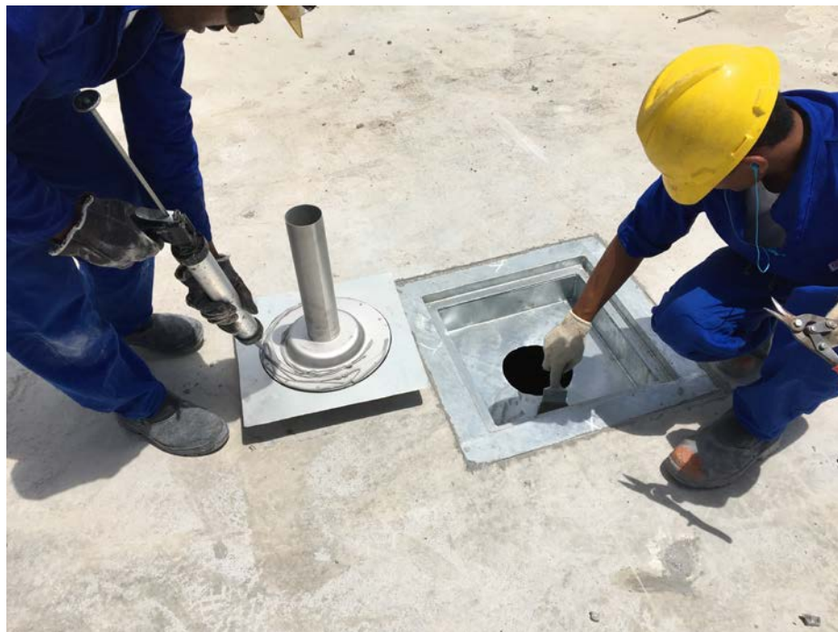
Figura 41 - Limpeza e aplicação do silicone na parte inferior do captador.
