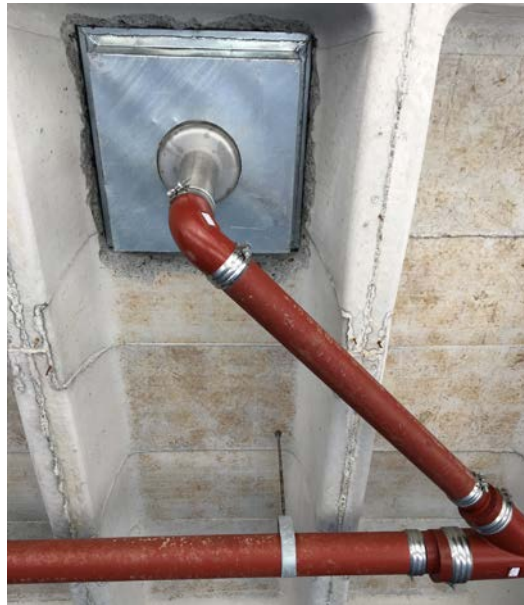
Figura 45 - Acoplamento do captador com a tubulação.
