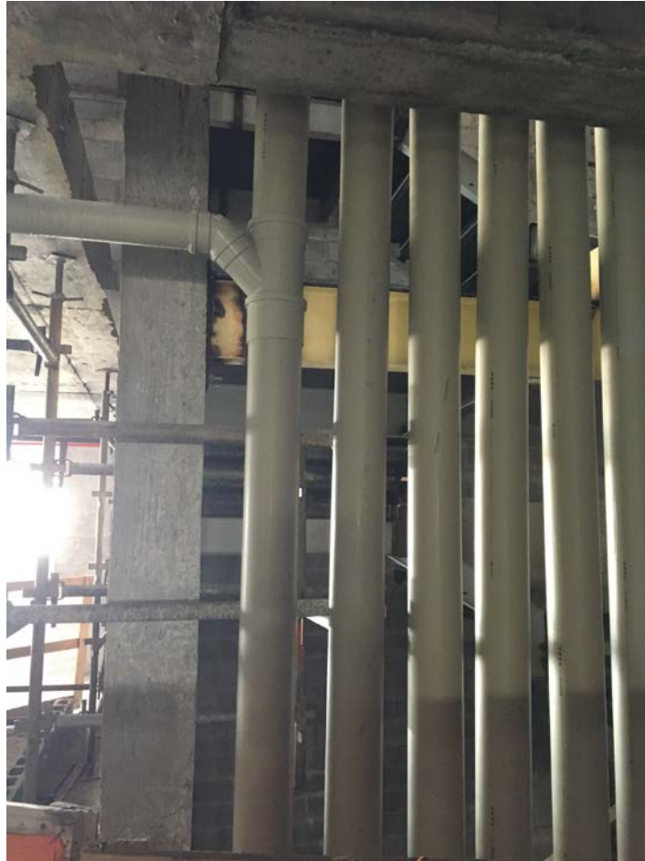
Figura 52 - Prumadas descendo pelos shafts próximo a escada.
