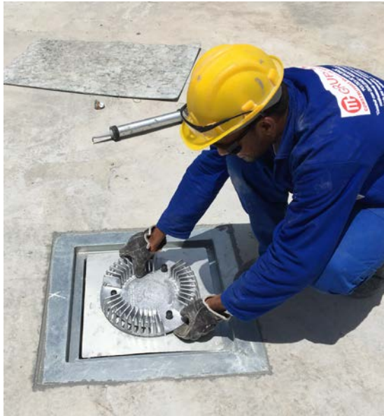
Figura 43 - Colocação do captador na caixa metálica.
