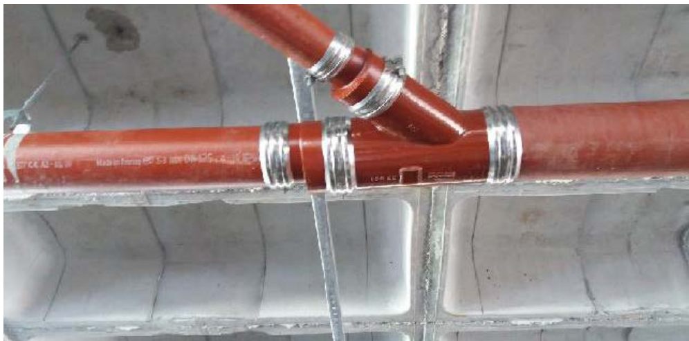
Figura 31 - Conexões e tubulações acopladas pela Junta Rapid.
