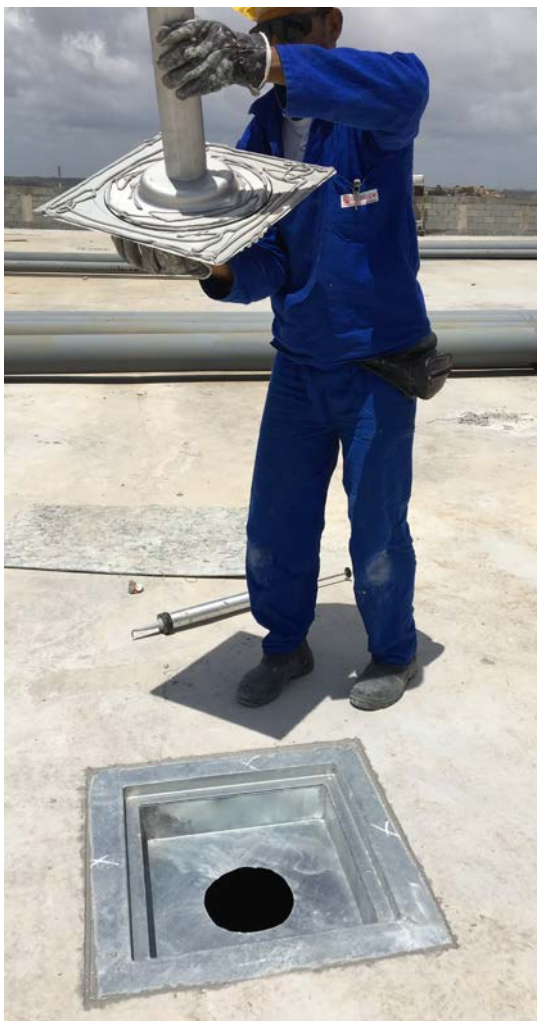
Figura 42 - Colocação do captador na caixa metálica.
