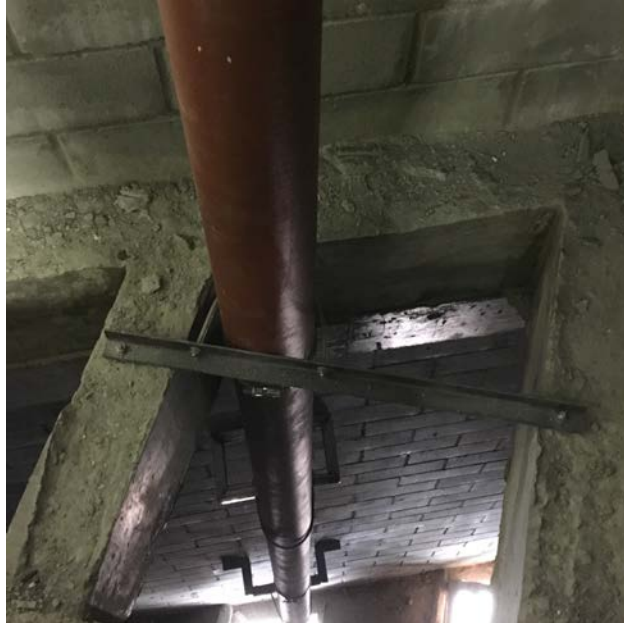
Figura 49 - Suportes metálicos das prumadas.
