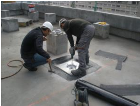
Figura 15. Instalação do captador sob a laje.
