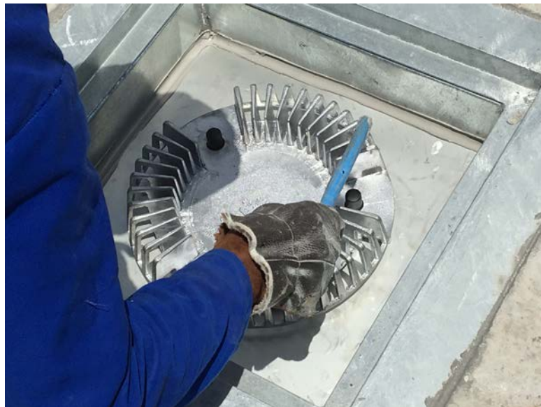
Figura 44 - Vedação e acabamento na superfície do captador.
