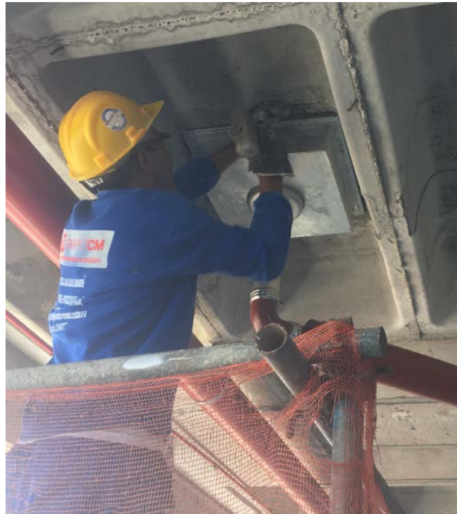
Figura 46 - Acabamento na parte inferior da caixa metálica.
