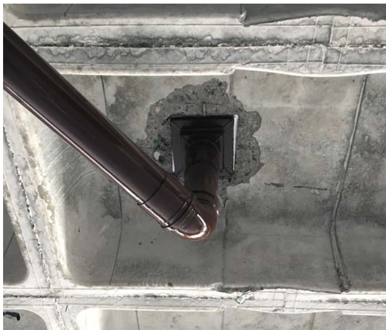
Figura 53 - Pintura da tubulação de água pluvial acoplada no ralo.
