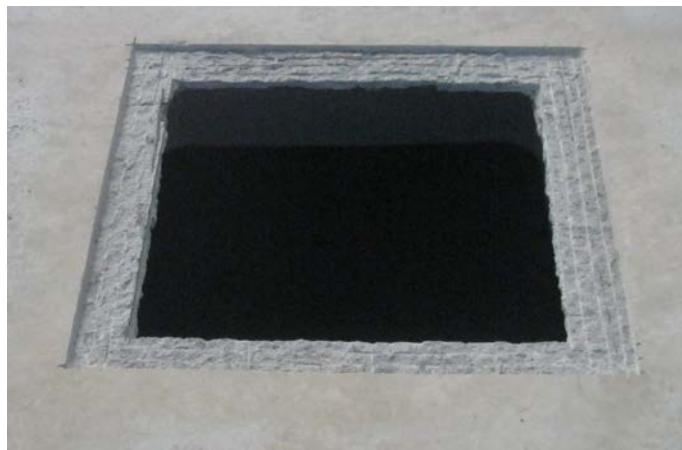
Figura 35 - Furo e desgaste na laje para colocação da caixa metálica.
