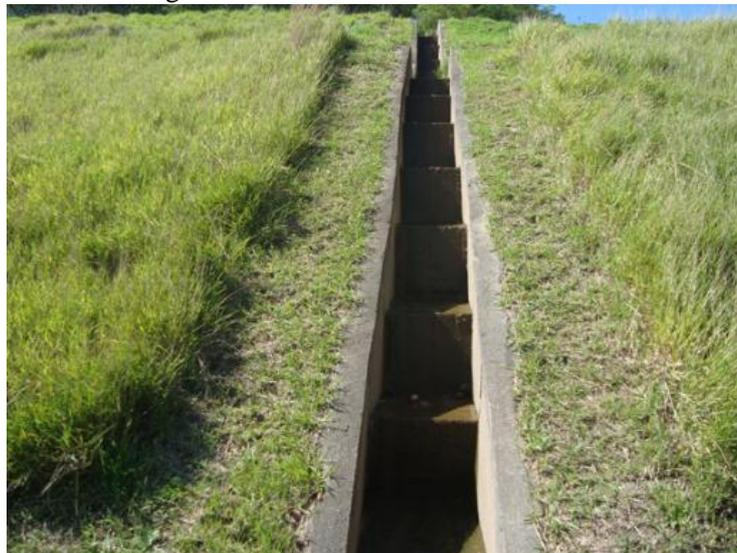
Figura 2.25 – Esquema geral de uma drenagem superficial em um talude rodoviário
