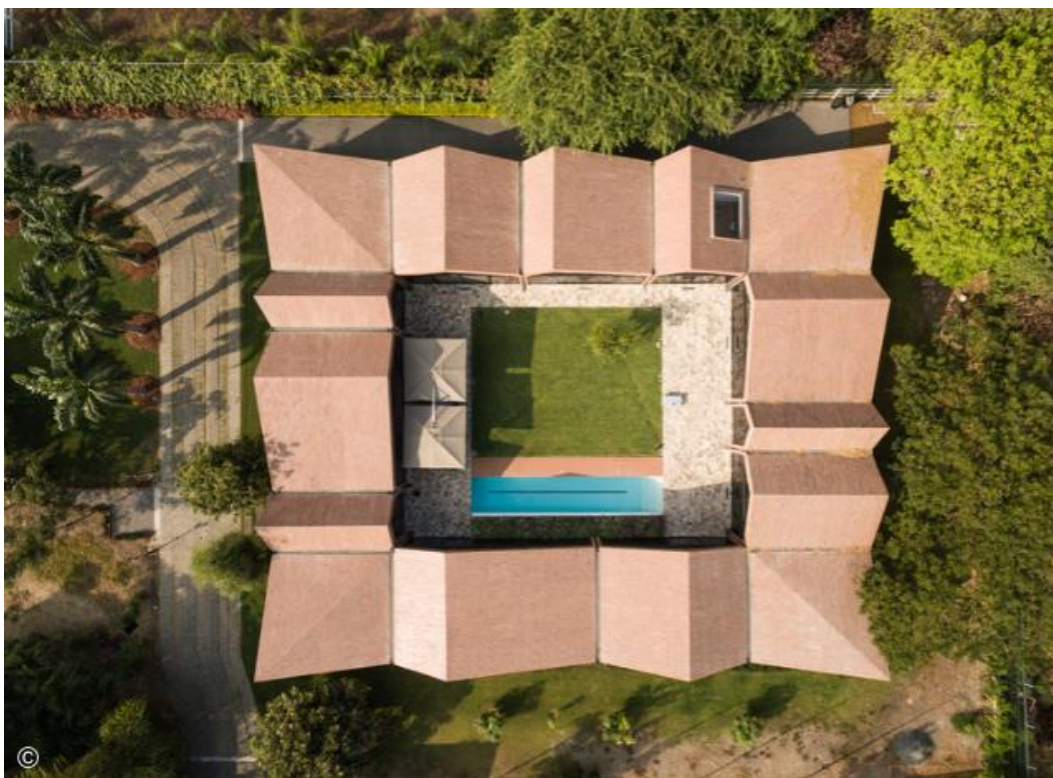
Figura 24– Vista superior da edificação
