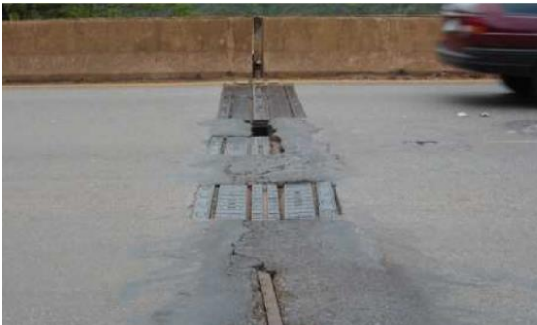
Figura 2.4 – Junta danificada no viaduto Procurador Paulo Lutterback Abreu em Belo Horizonte (foto SINAENCO).
