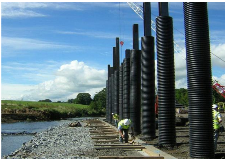
Figura 2.30 – Estacas metálicas envoltas por tubos de plástico utilizadas em encontro integral no Reino Unido (ILES, 2010).
