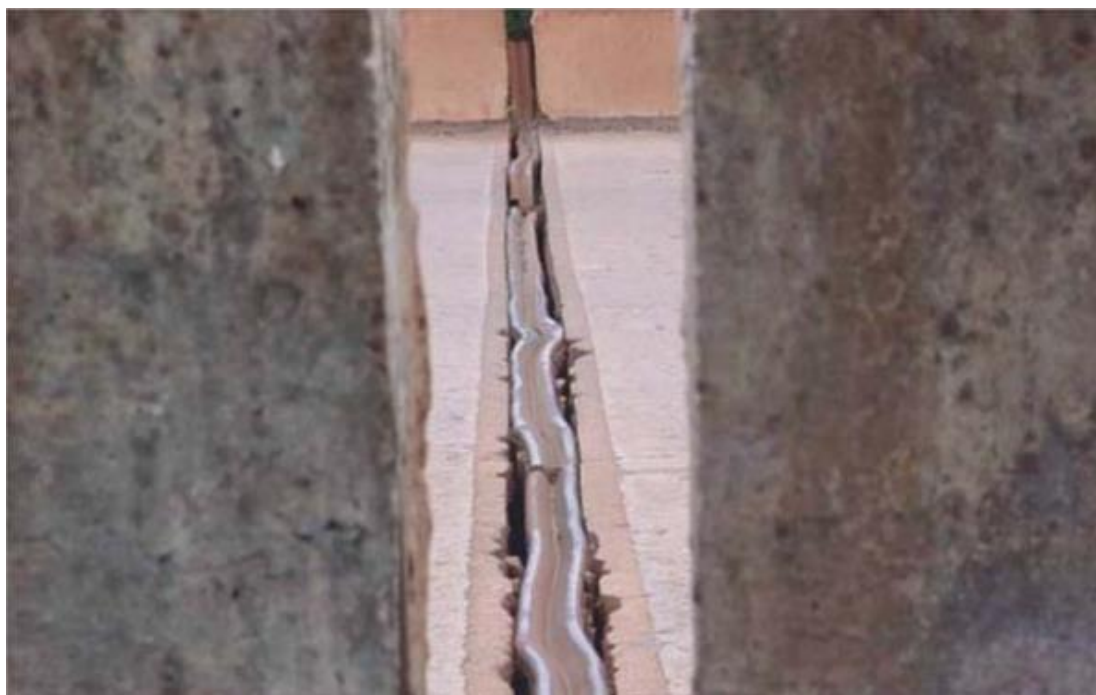
Figura 2.5 – Junta danificada no viaduto do Mutuca-Antigo em Belo Horizonte (foto DNIT).
