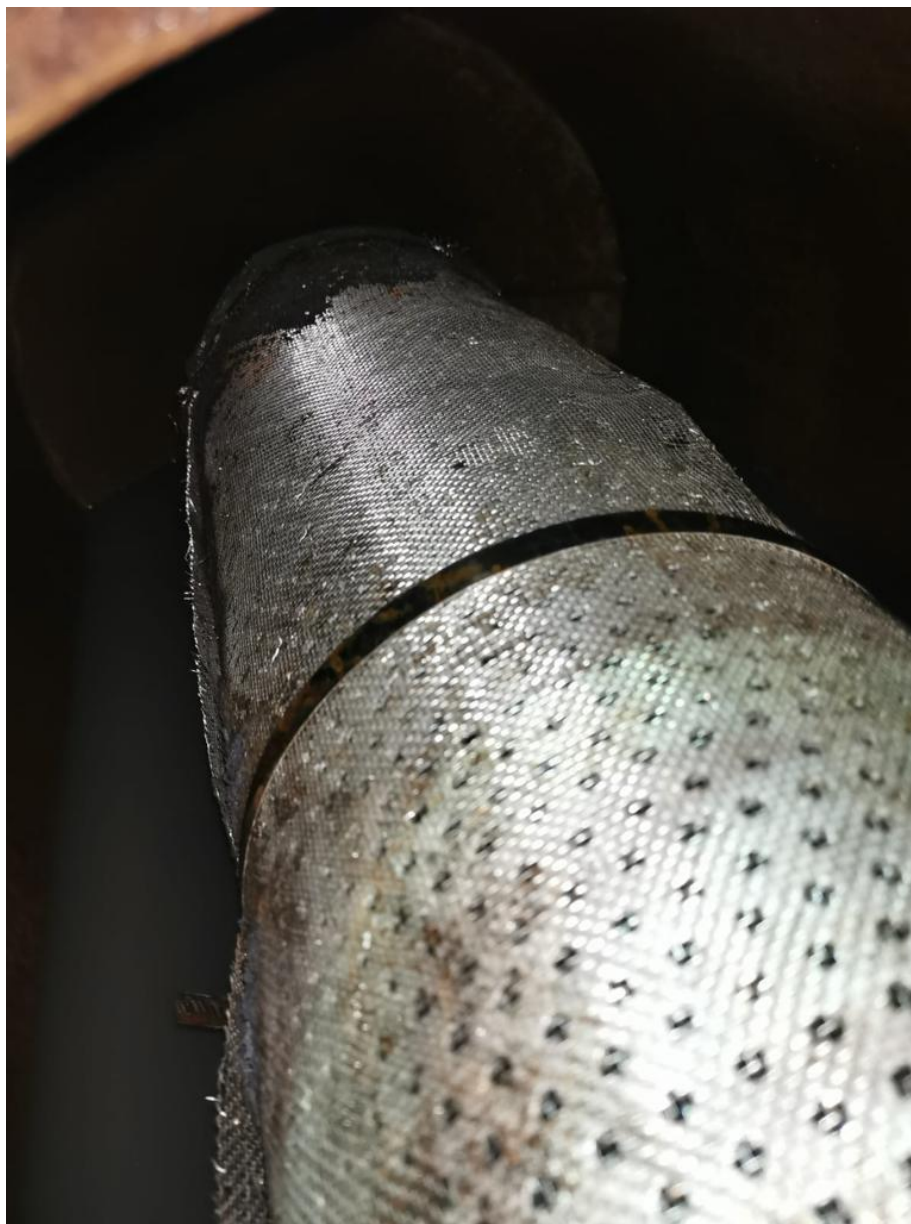
Apêndice 2: Interior do separador de mistura após primeira limpeza
