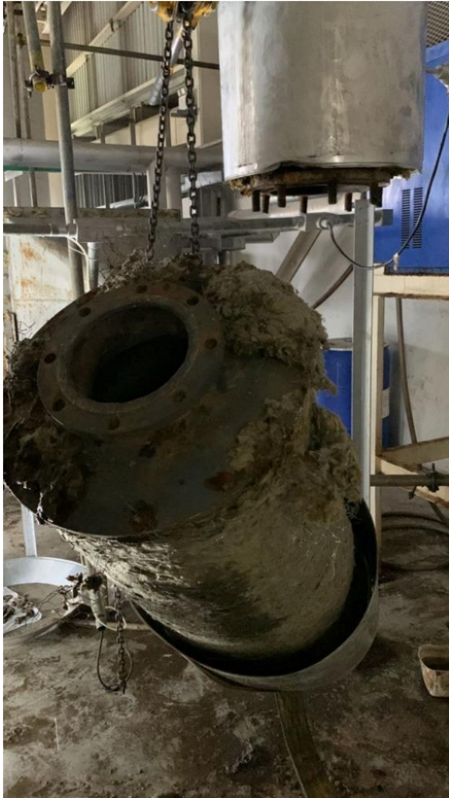
Apêndice 1: Separador de mistura sendo retirado
