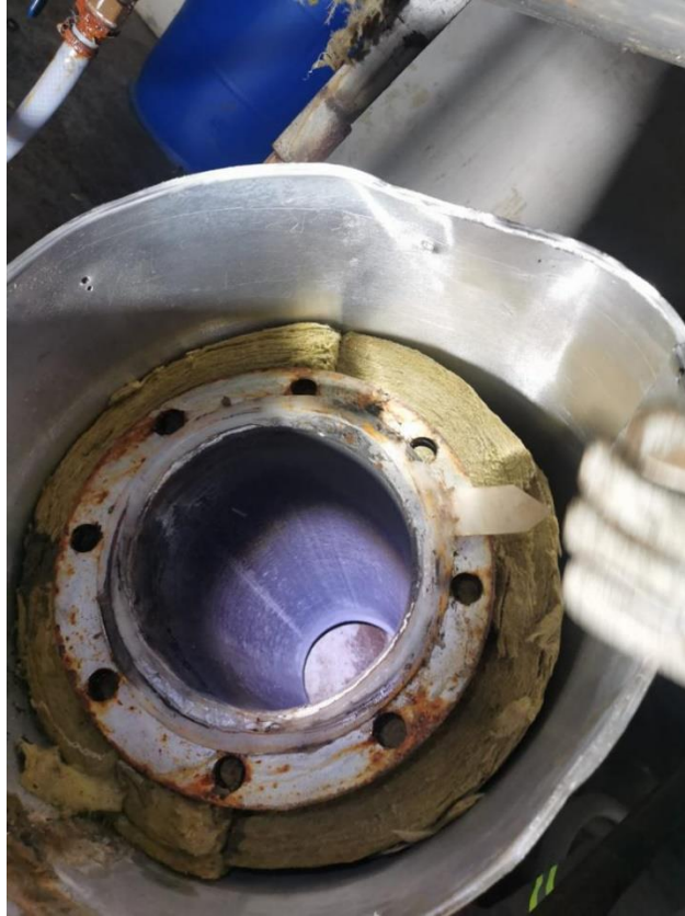
Apêndice 4: Tubulação do separador de mistura por onde passa o ar
