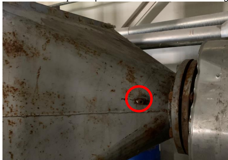
Figura 14: Ponto de medição de pressão entrada da bateria de água gelada.
