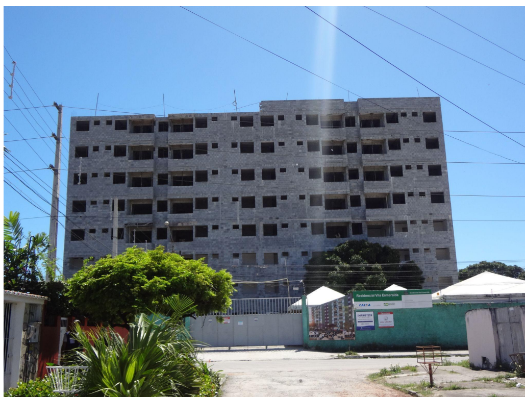
Imagem 42: Condomínio Vila Esmeralda, ainda em construção. III etapa de Rio Doce. 2022 Fonte: Acervo da autora
