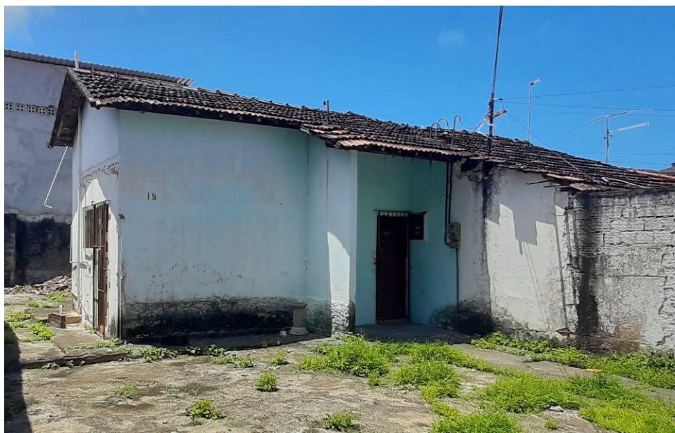
Imagem 23 - Casa original da COHAB, Rua das Margaridas, Rio Doce, II etapa, 2022. Fonte: Acervo da Autora
