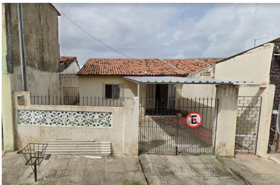
Imagem 25 - Casa da COHAB modificada, Rua das Margaridas, Rio Doce, II etapa. Fonte: Google Maps
