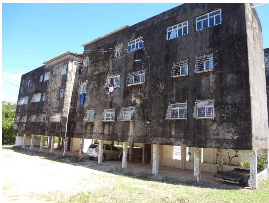
Imagem 27 - Detalhe do térreo de um edifício da COHAB na IV etapa de Rio Doce, no modelo “quadra aberta”, 2022. Fonte: Acervo da autora
