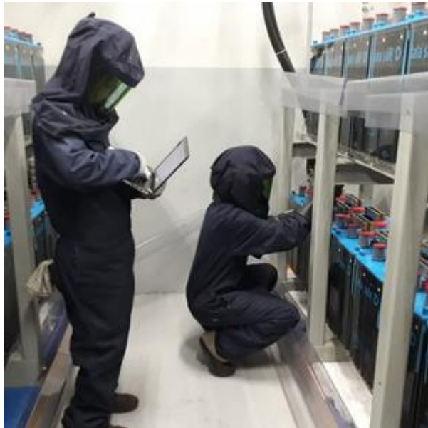
Figura 10 - Inspeção na sala de baterias
