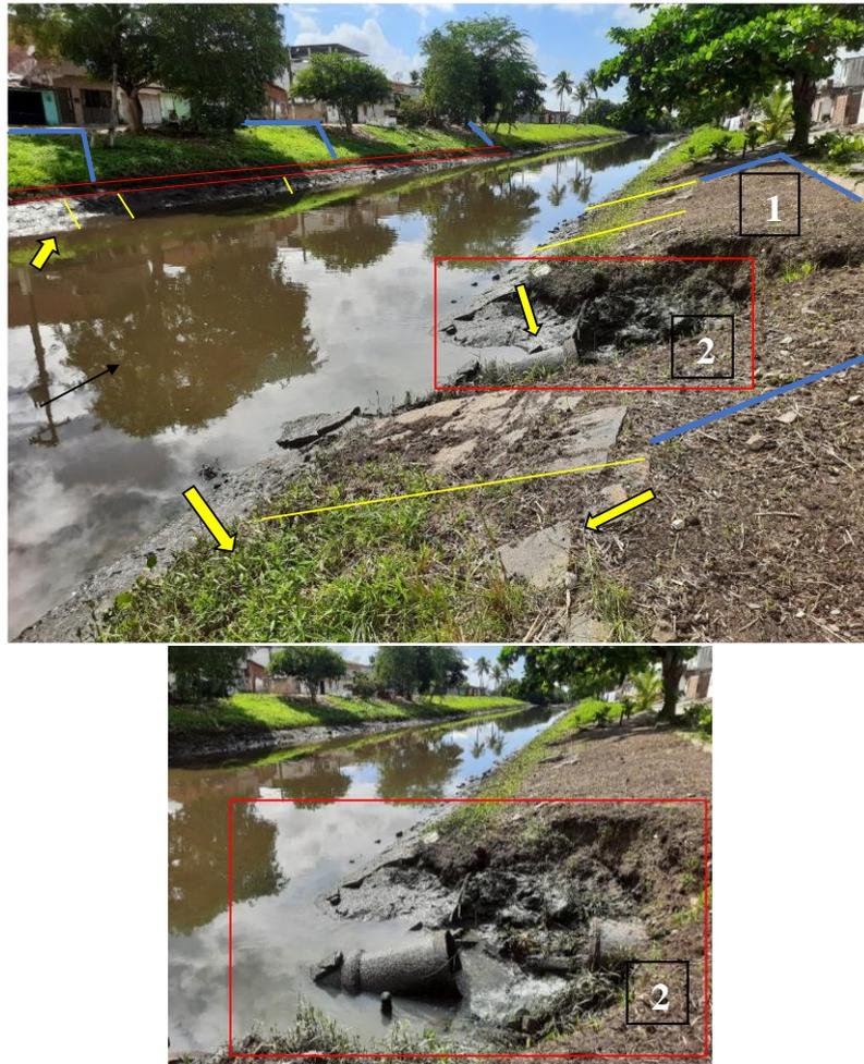
A exposição dos dejetos é resultante de uma ruptura no sistema de drenagem que ocasionou a subsidência do terreno e, por conseguinte, o desenvolvimento de uma frente erosiva ativada pelo escoamento das águas lançadas pela tubulação rompida.
