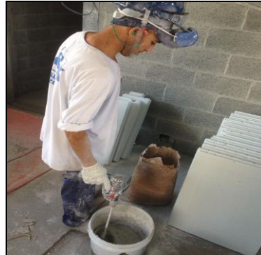
Figura 7: Preparação do gesso cola através do misturador eletromecânico.
