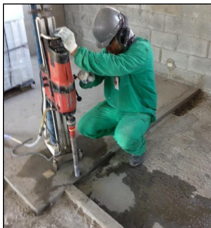
Figura 15: Furação da laje antes do assentamento do bloco para a passagem das instalações.
