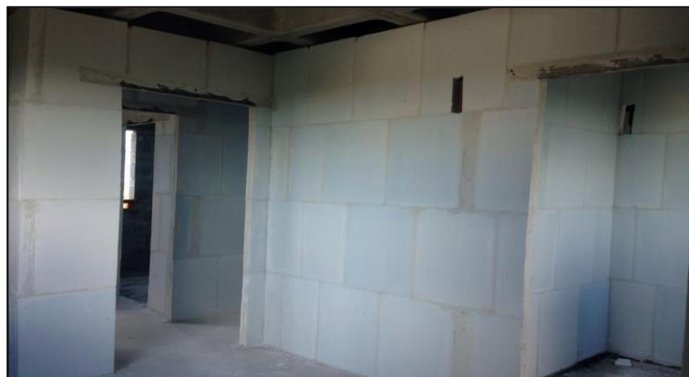
Figura 12: Transpasse das vergas das portas nos blocos de gesso.
