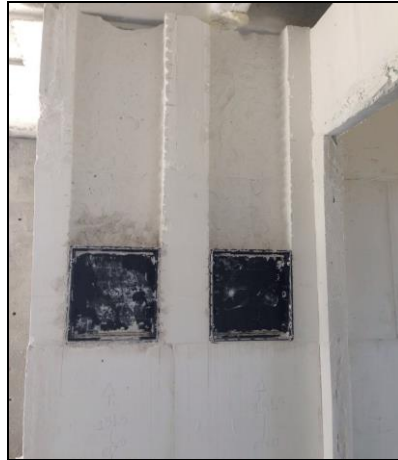
Figura 30: Rasgos na alvenaria para passagem das tubulações para os quadros elétricos e de conectividade.
