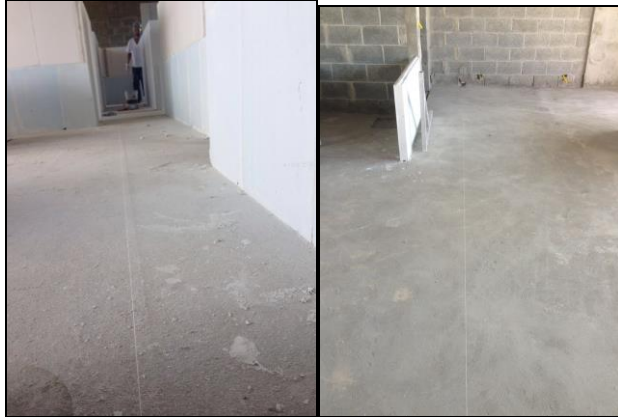
Figura 6: Marcação das alvenarias em bloco de gesso.
