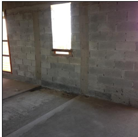
Figura 3: Paredes chapiscadas no trecho que terá contato com a alvenaria.
