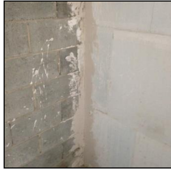
Figura 10: Aplicação da tela de poliéster no encontro entre bloco de gesso e alvenaria externa.
