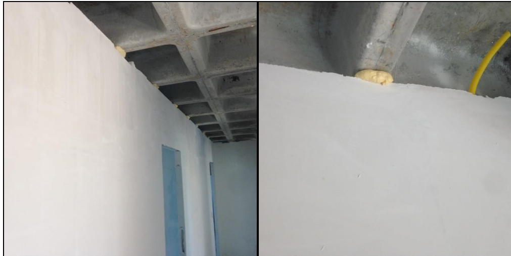
Figura 13 e 14: Encunhamento das alvenarias em bloco de gesso nas lajes.
