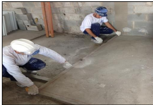
Figura 6: Marcação das alvenarias em bloco de gesso.
