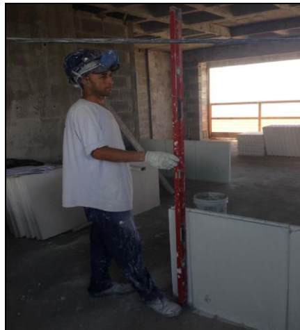
Figura 11: Conferência de prumo das alvenarias em bloco de gesso.
