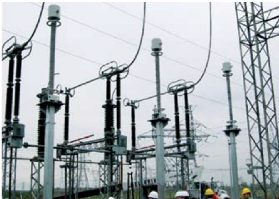
Figura 14: TC's Ópticos instalados na subestação 315 kV AIS, La Praiere - Canadá
