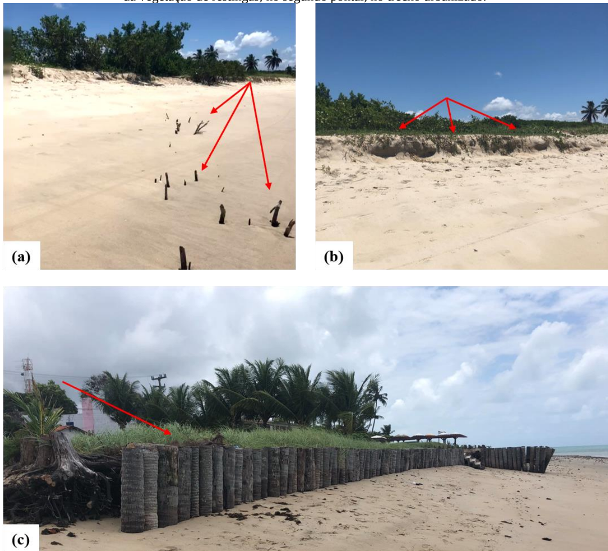
Figura 5 - (a) representa a exposição, no estirâncio, de raízes de plantas erodidas pela ação de ondas; (b) exhibe a atuação de processos erosivos na base da vegetação, danificando-as, ambas localizadas no trecho protegido sob influência do Rio Mamucabas e (c) mostra a artificialização da LC por obras rígidas, o parcelamento e supressão da vegetação de restingas, no segundo pontal, no trecho urbanizado.
