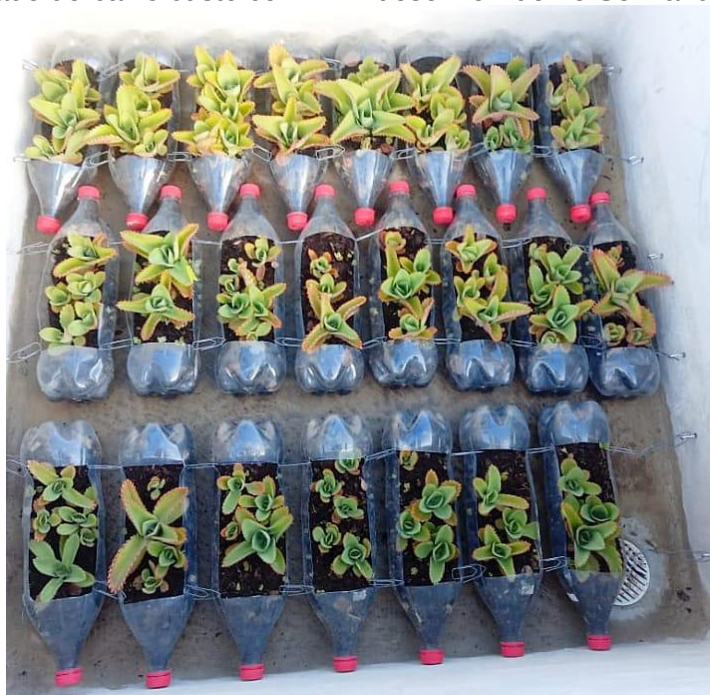
Figura 10 - Telhado de baixo custo com PET desenvolvido no Semiárido pernambucano.
