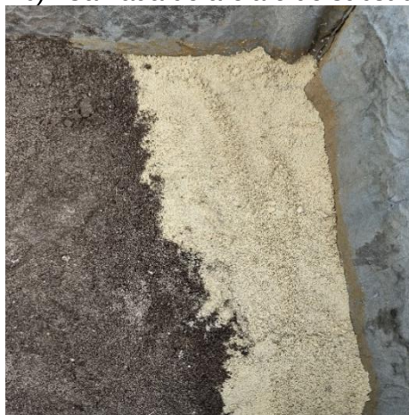
Figura 14 - Montagem do telhado verde convencional, na CT 5.
