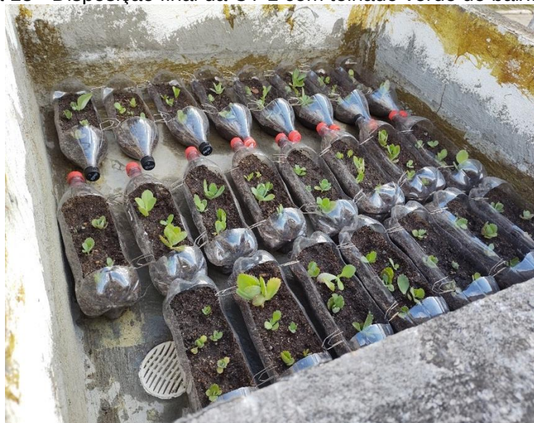
Figura 13 - Disposição final da CT 1 com telhado verde de baixo custo.
