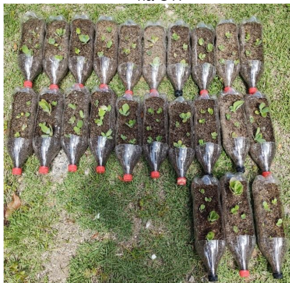
Figura 12 - Montagem do telhado verde de baixo custo, na CT 1.
