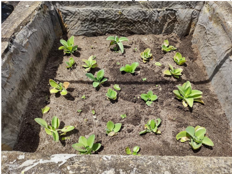
Figura 15 - Telhado verde convencional, com vegetação Kalanchoe laetivirens , na CT 5.
