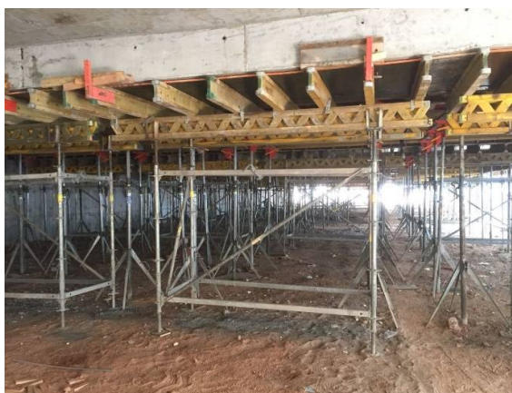
Figura 5 – Foto de Obra pela PERI em Paulista, lajes e vigas protendidas
