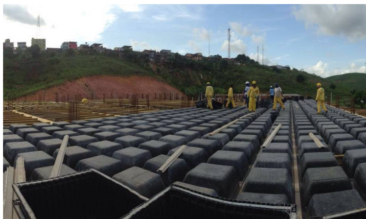
Figura 3 – Foto de Obra pela PERI em caruaru, utilizando linhas guias para apoio
