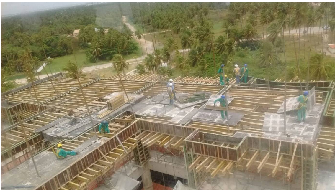
Figura 35 - Finalização do barroteamento, e posicionamento dos compensados
