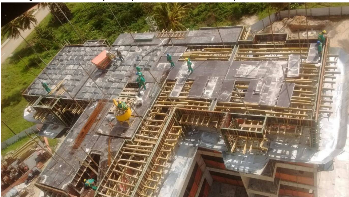
Figura 36 - Finalização do posicionamento dos compensados e início dos moldes
