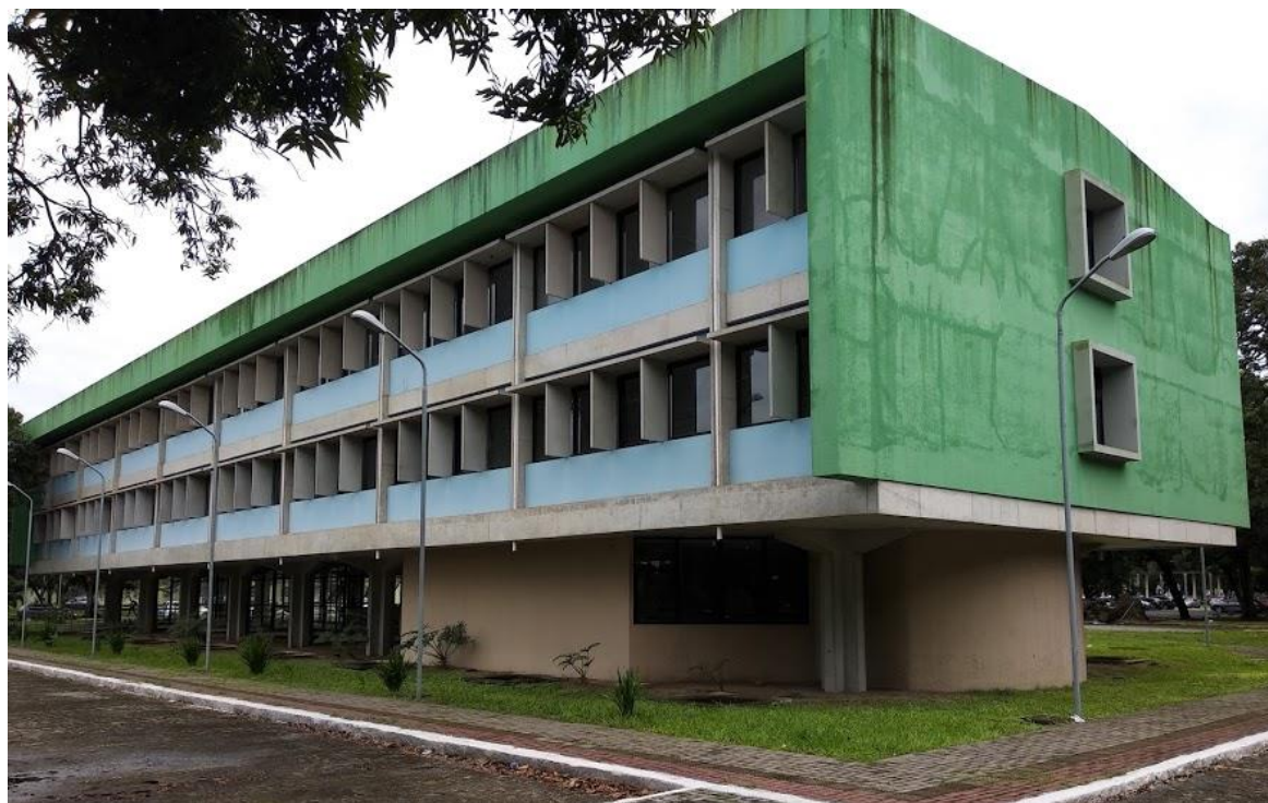
Figura 8 - Fachadas Sul e Leste da edificação.
