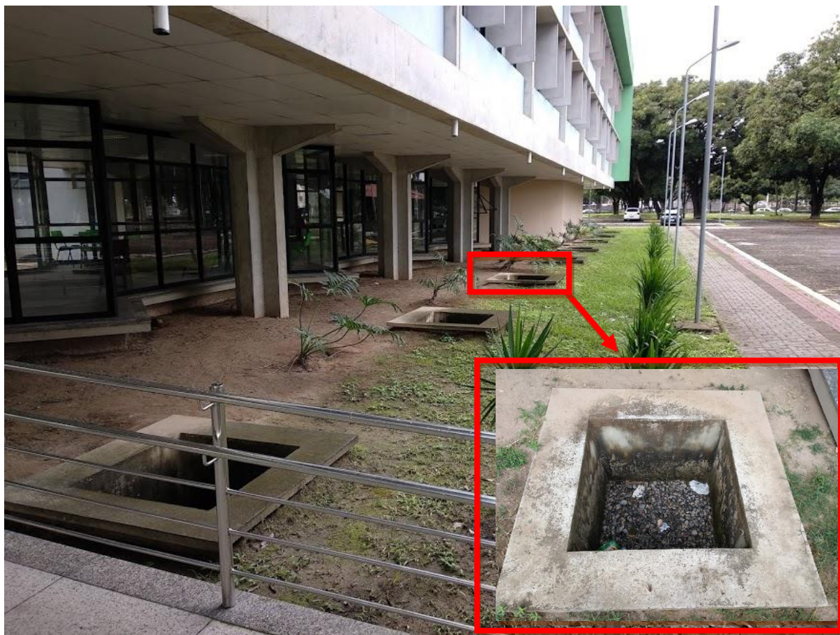
Figura 14 - Caixas filtrantes.
