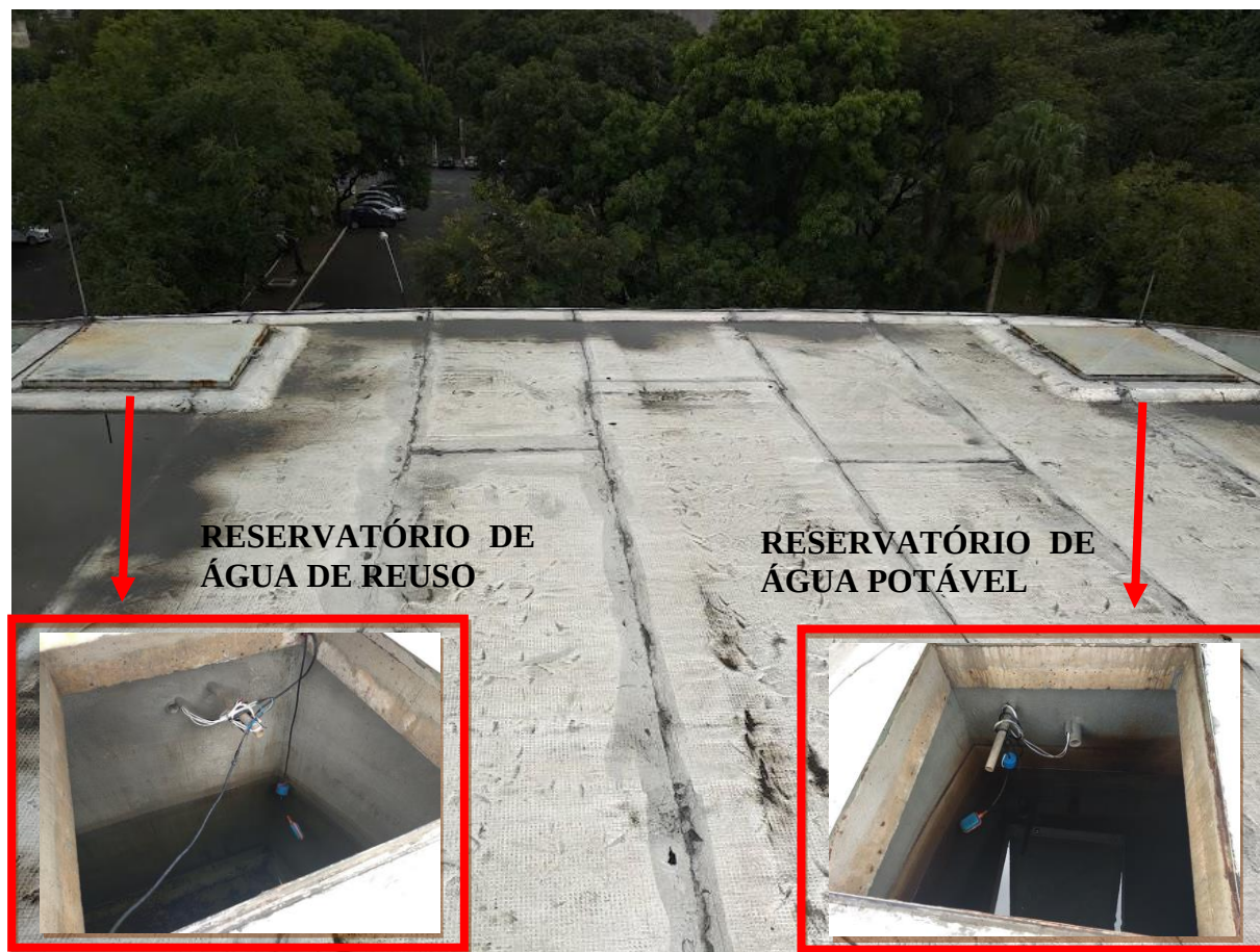
Figura 21 - Reservatórios superiores.
