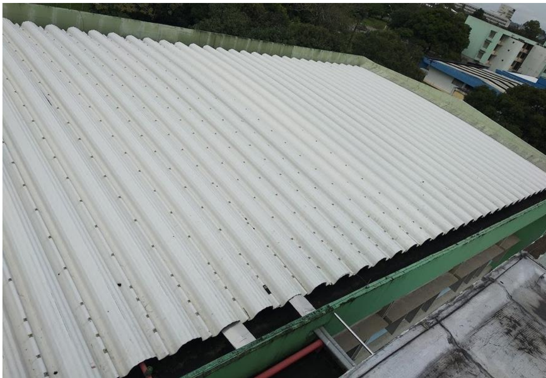
Figura 10 - Cobertura principal da edificação.
