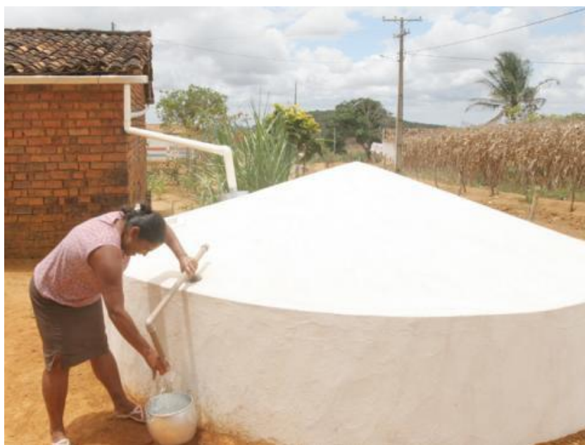
Figura 3 - Cisterna para armazenamento de água pluvial com captação pelo telhado
