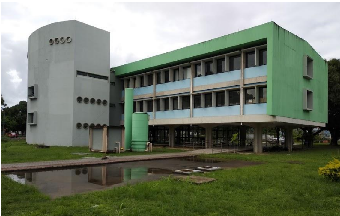
Figura 7 - Fachadas Norte e Oeste da edificação.
