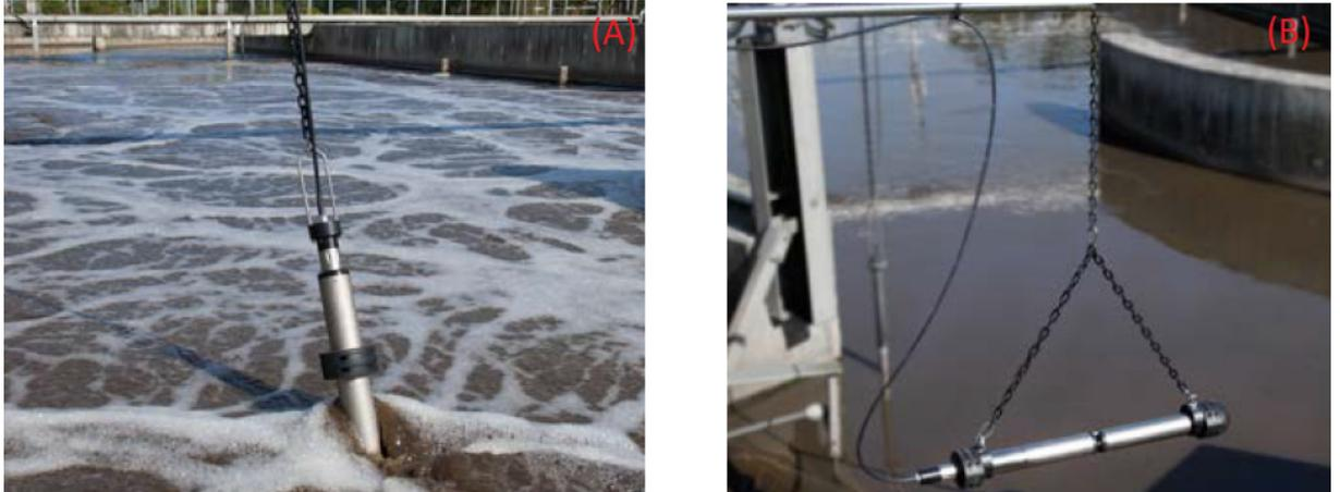
Em (A), a instalação vertical. Em (B), o dispositivo é instalado horizontalmente
