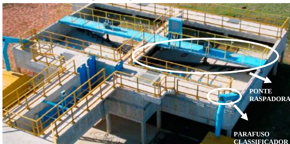
Figura 8 - Esquema de um desarenador
