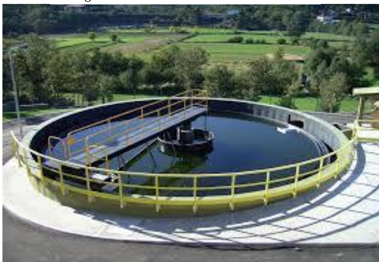
Figura 12 - Foto retirada de um decantador
