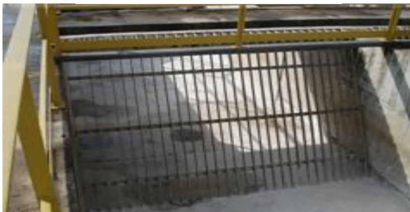
Figura 7 - Gradeamento Manual
