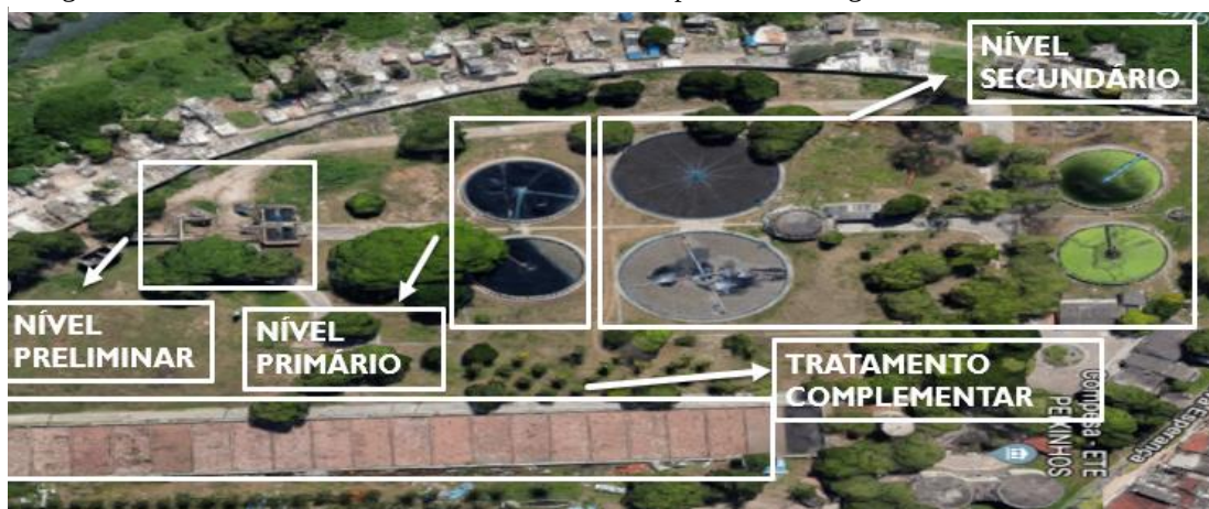
Figura 5 - Vista de cima de uma ETE com tratamento por filtro biológico e decantador secundário
