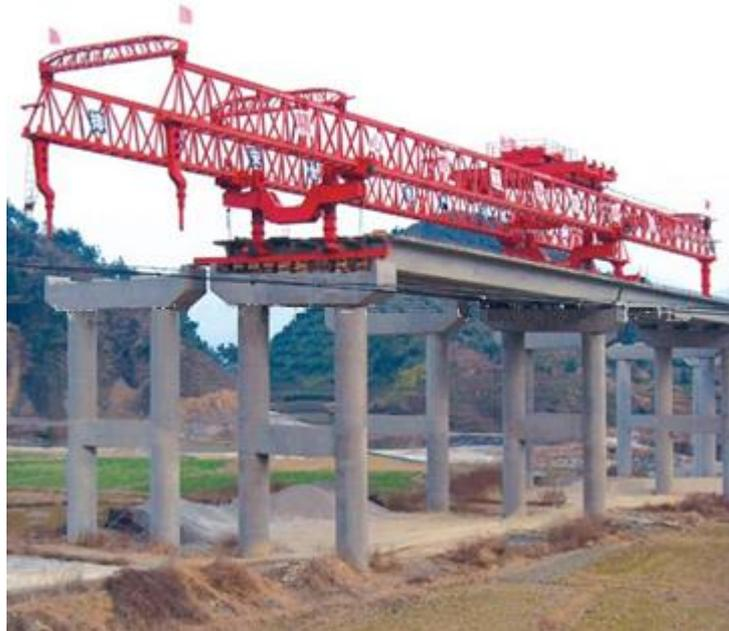
Figura 4.1 - Vigas pré-moldadas sendo posicionadas por treliça lançadeira.
