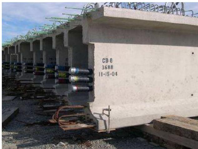
Figura 4.2 - Viga com armadura para continuidade posterior (PINHO, 2011).
