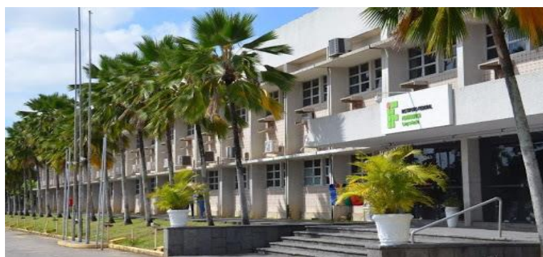
Figura 28 -Entrada principal do IFPE campus Recife, área externa.
