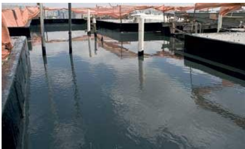
Figura 9-Teste de estanqueidade
