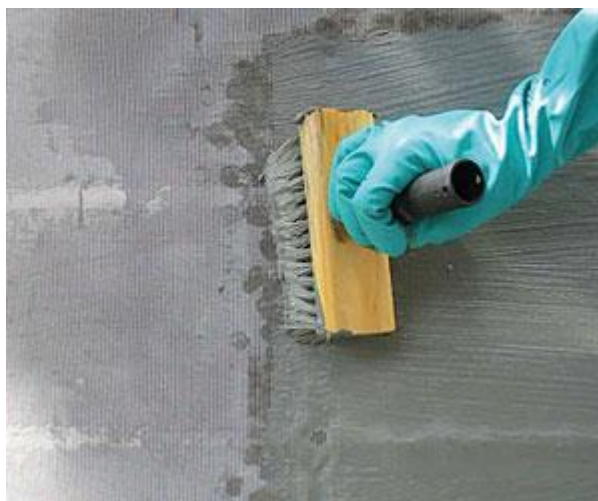
Figura 14--Camada executada com trincha
