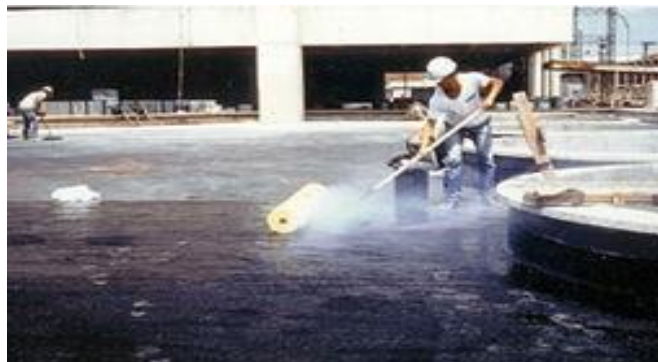
Figura 13-Aplicação de proteção mecânica
