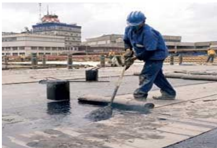
Figura 5-Aplicação da Manta a quente
