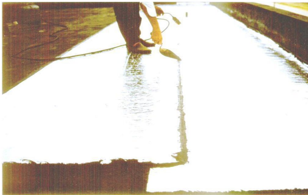
Figura 1-Manta asfáltica com acabamento em folha de alumínio
