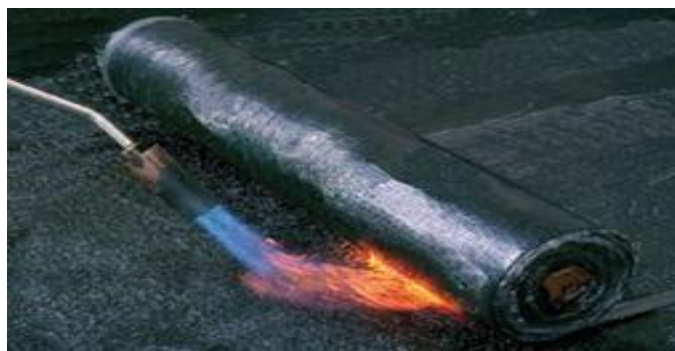
Figura 6-Aplicação da manta com maçarico
