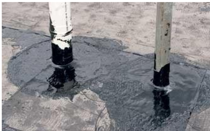
Figura 8-Detalhe de Arremate em tubulações
