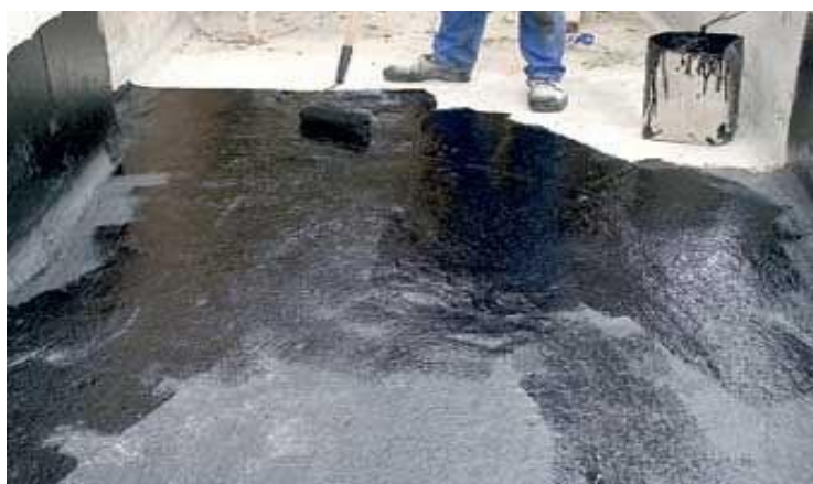
Figura 4-Aplicação do primer (Imprimação)
