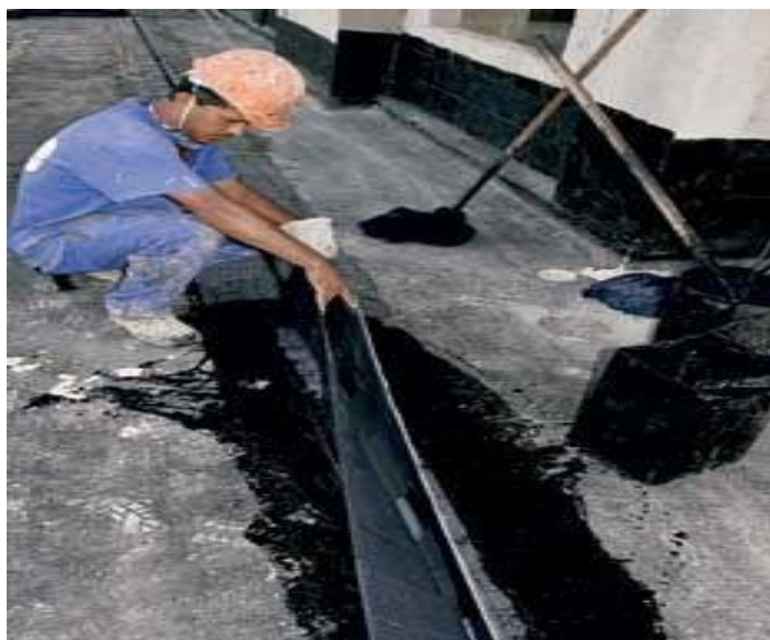
Figura 3-Preparação das juntas
