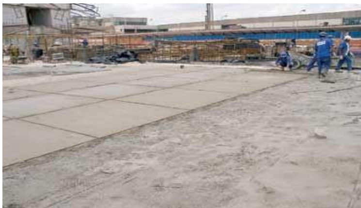
Figura 10-Proteção Mecânica para manta
