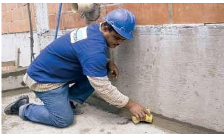
Figura 2-Preparação da superfície
