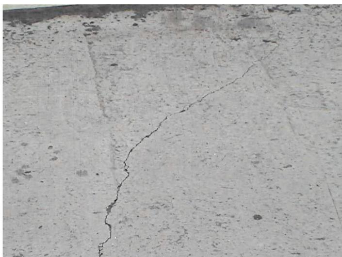
Figura 8: Fissura Diagonal (Fonte: DNIT 061/2004).
