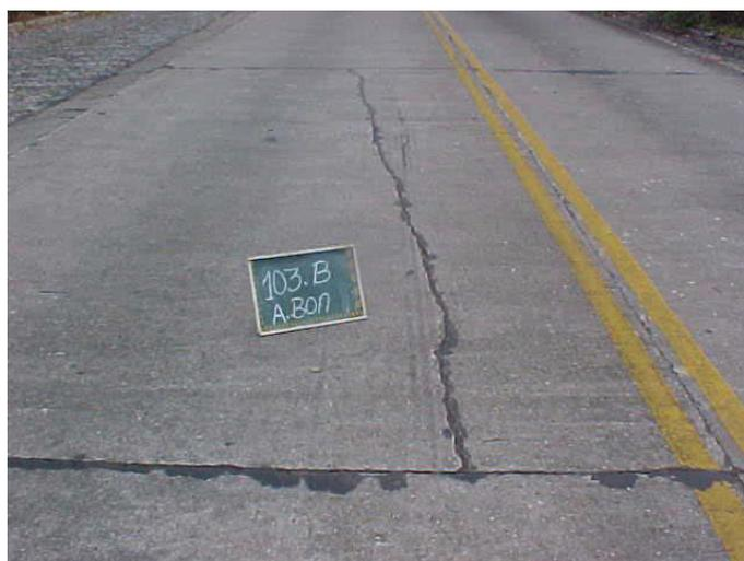
Figura 11: Fissura longitudinal (Fonte: DNIT 061/2004).
