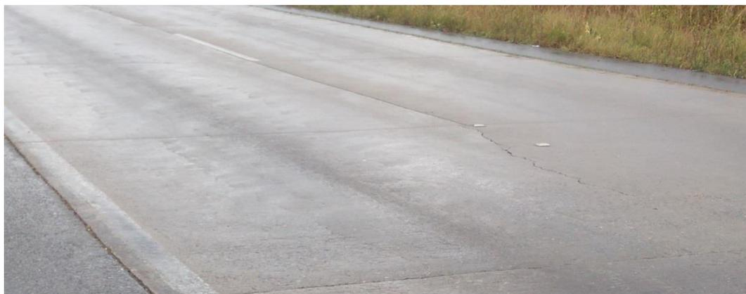
Figura 17: Junta de ligação entre o PEA e as placas de concreto simples.
