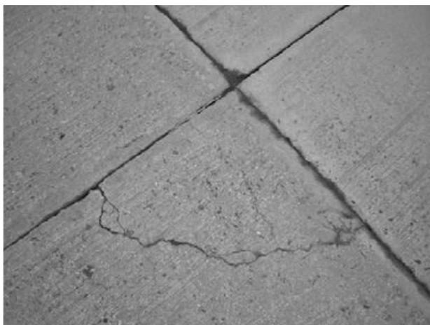
Figura 12: Fissura de canto em placa de concreto simples (Fonte: MAGGI, 2006).
