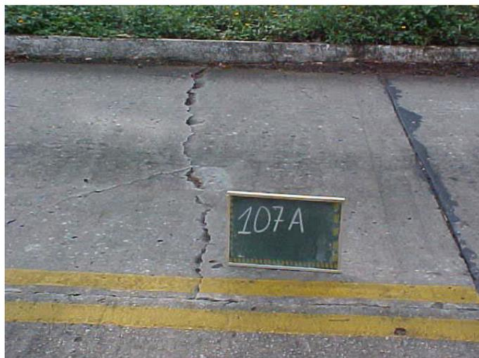
Figura 9: Fissura transversal (Fonte: DNIT 061/2004).
