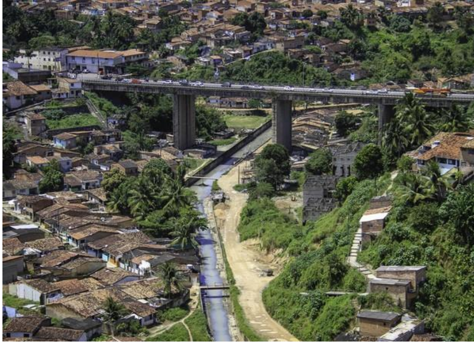
Figura 23 – Vale do Reginaldo, trecho cortado pela Av. Gov. Afrânio Lages – Leste Oeste.
