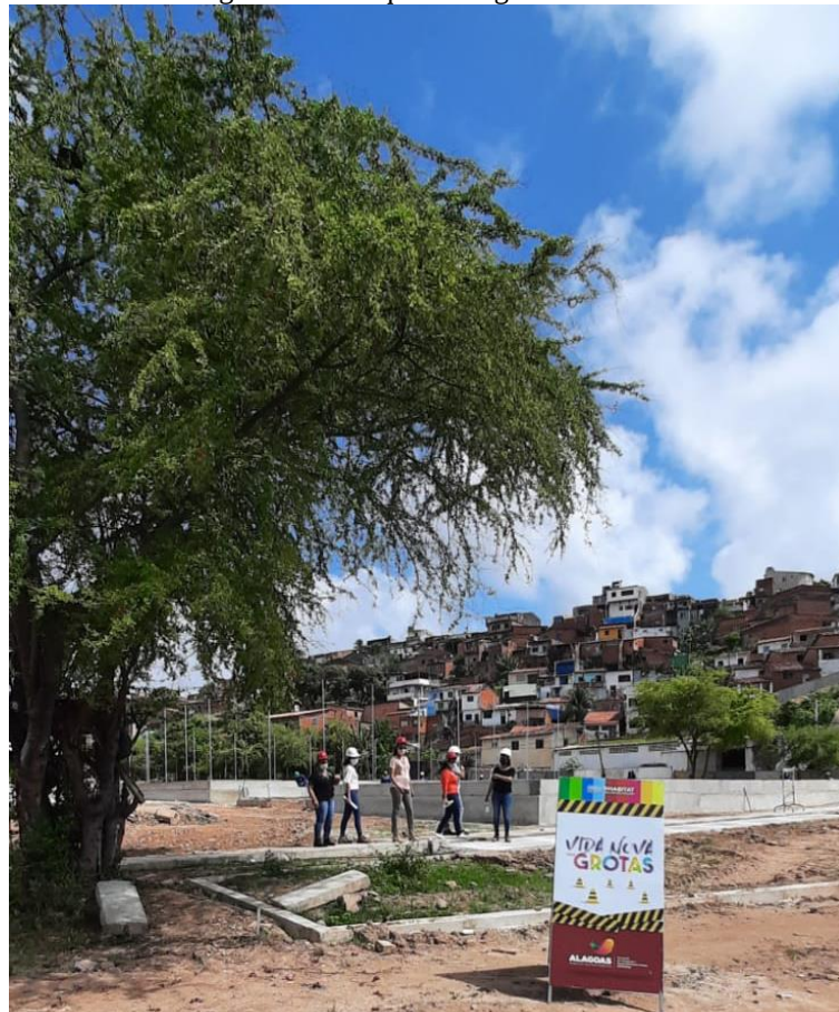
Figura 42 – Parque do Cigano em obra.
