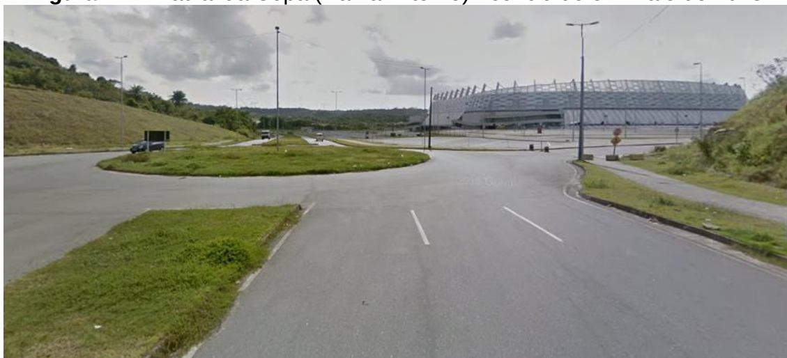
Figura 27 - Radial da Copa (Ramal Interno) - concluído em maio de 2013.
