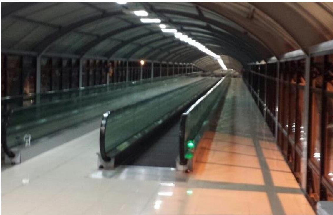
Figura 16 - Passarela do Metrô ao Aeroporto – vista interna.
