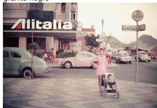
Figura 142 - O embasamento do edifício começa a ser modificado com a retirada do granito negro
