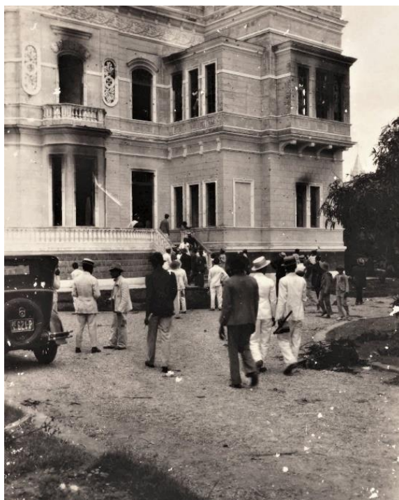
Figura 110 – Residência José Pessoa de Queiroz após o incêndio
