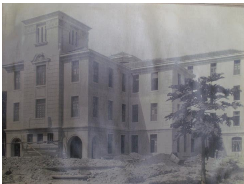
Figura 74 - Hospital do Centenário em fase de conclusão, sem data.
