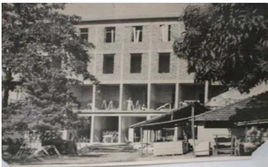
Figura 73 - Hospital do Centenário em Construção, sem data.
