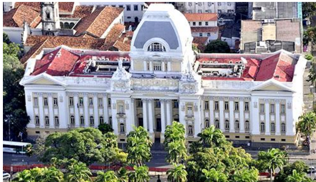
Figura 29 - Fachada Principal do Palácio da Justiça
