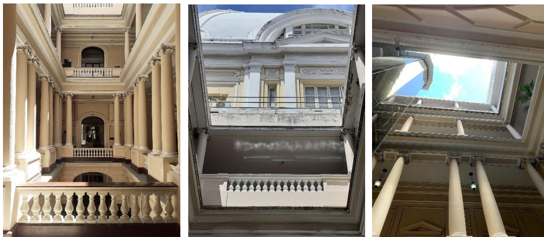
Figura 35 – Pátio interno e cúpula
