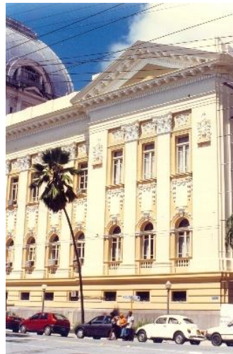
Figura 30 – Fachada do Pavilhão lateral
