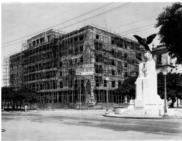
Figura 41 – Grande Hotel em Construção na década de 1936 pela empresa Cesar Mello
