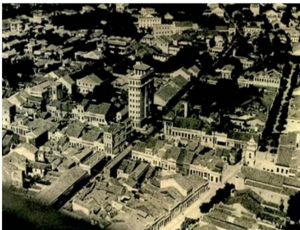
Figura 48 - Vista aérea do Hotel Central no Bairro da Vista
