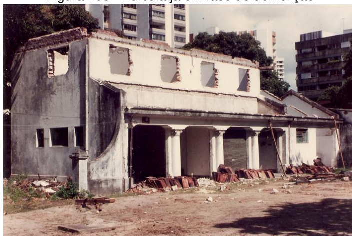
Figura 108 - Edícula já em fase de demolição
