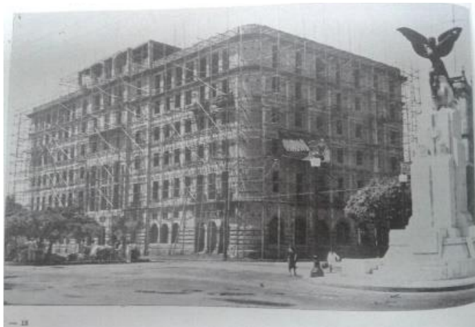
Figura 40 – Grande Hotel em Construção na década de 1920 pela Empresa Brandão e Magalhães
